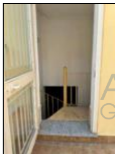
Scala accesso deposito 2
