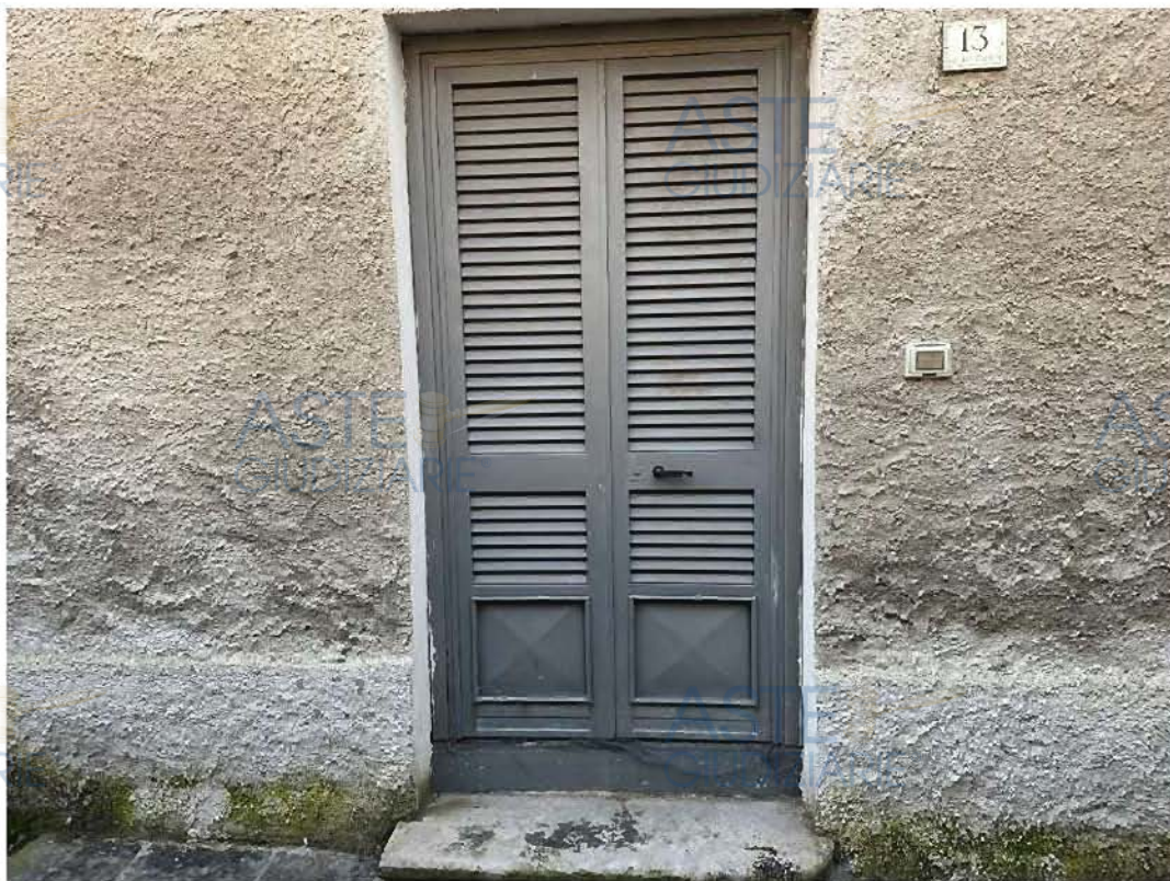
6) FOTO: INGRESSO CON PORTONCINO SU VIA DEI GIARDINI PER ACCEDERE ALL'IMMOBILE
