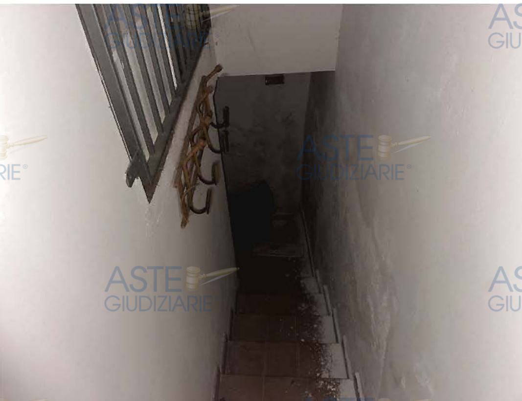
9) FOTO: SCALA PER ACCEDERE DAL PIANO TERRA AL PIANO INTERRATO
