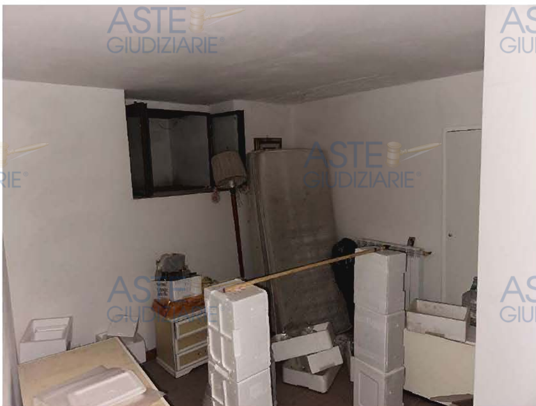
11) FOTO: INTERNO DEL PIANO INTERRATO DELL'IMMOBILE PIGNORATO
