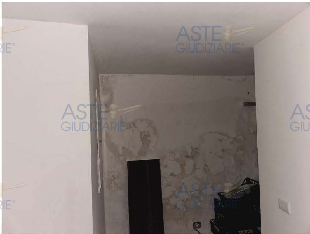
10) FOTO: INTERNO DEL PIANO INTERRATO DELL'IMMOBILE PIGNORATO
