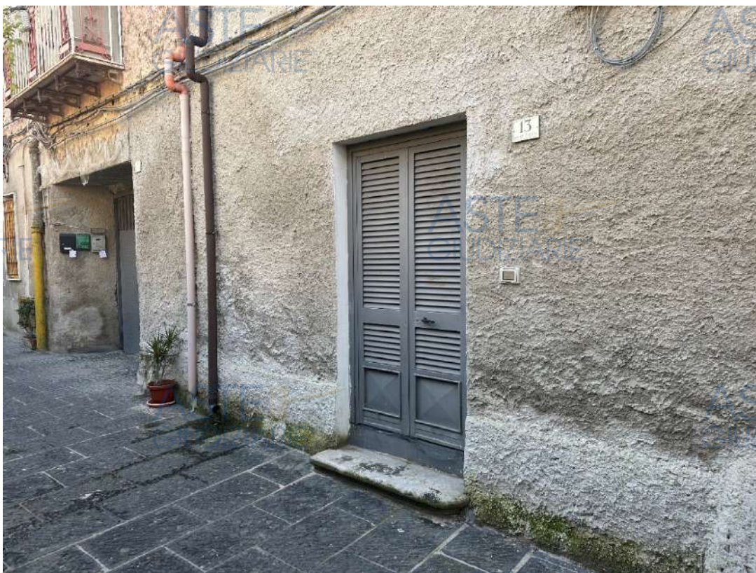
5) FOTO: INGRESSO CON PORTONCINO SU VIA DEI GIARDINI PER ACCEDERE ALL'IMMOBILE
