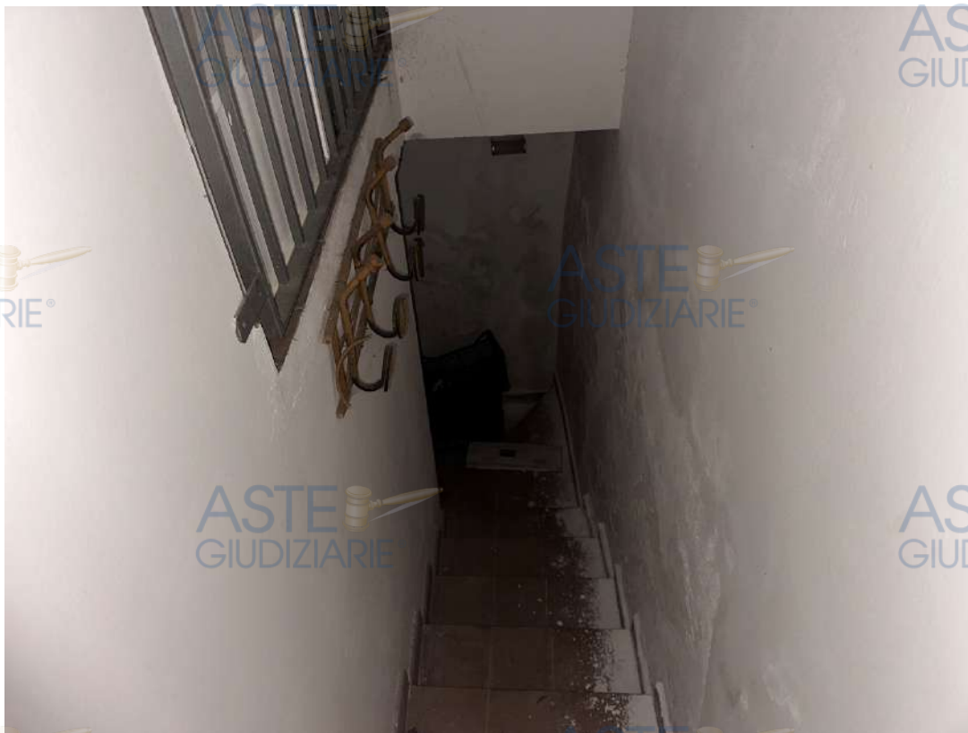
9) FOTO: SCALA PER ACCEDERE DAL PIANO TERRA AL PIANO INTERRATO
