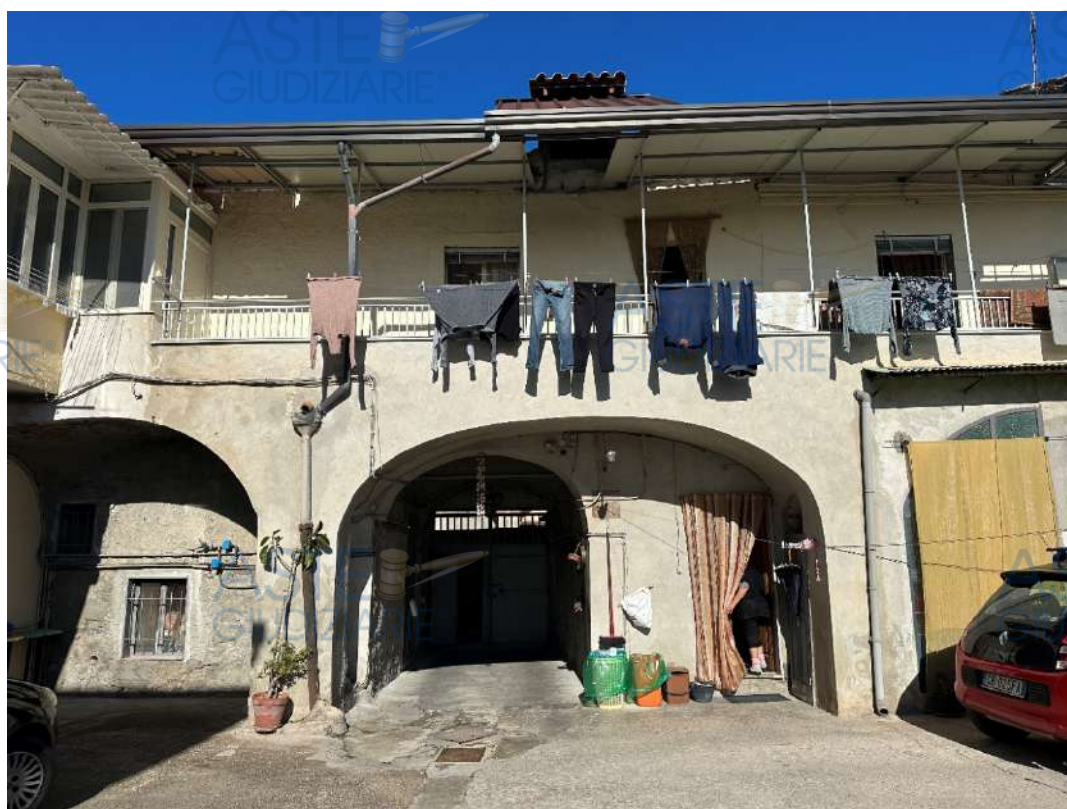
7) FOTO: FACCIATA SUL CORTILE INTERNO (NON DI PROPRIETA' MA IN COMUNE CON LE ALTRE PROPRIETA')
