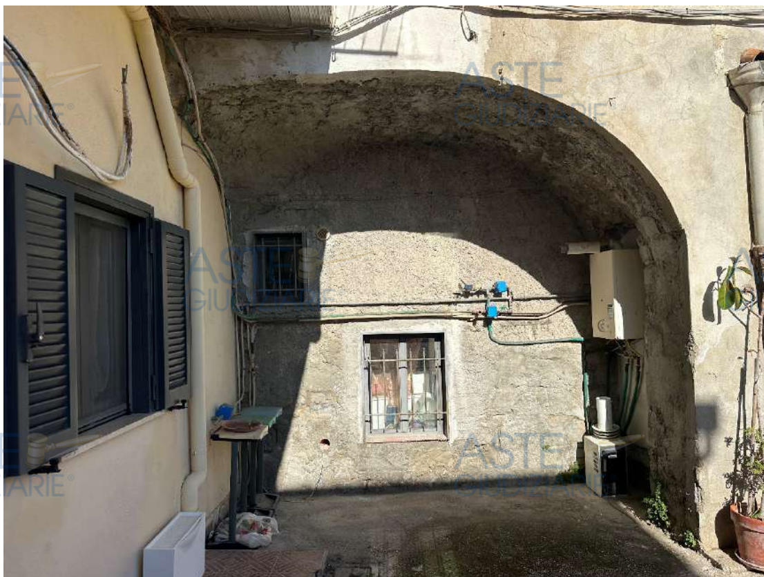
2) FOTO: FINESTRE CON GRATE IN FERRO POSTE SULLA FACCIA POSTERIORE DEL CORTILE
