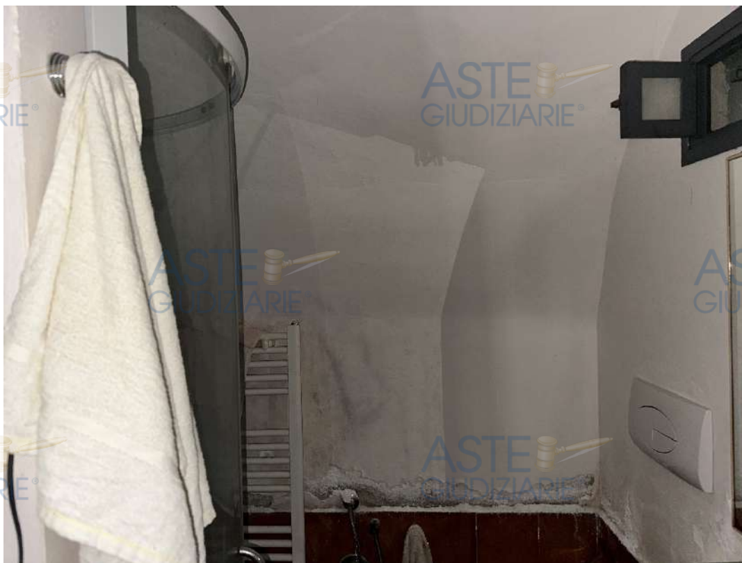
8) FOTO: INTERNO DEL BAGNO DELL'IMMOBILE PIGNORATO POSTO AL PIANO TERRA
