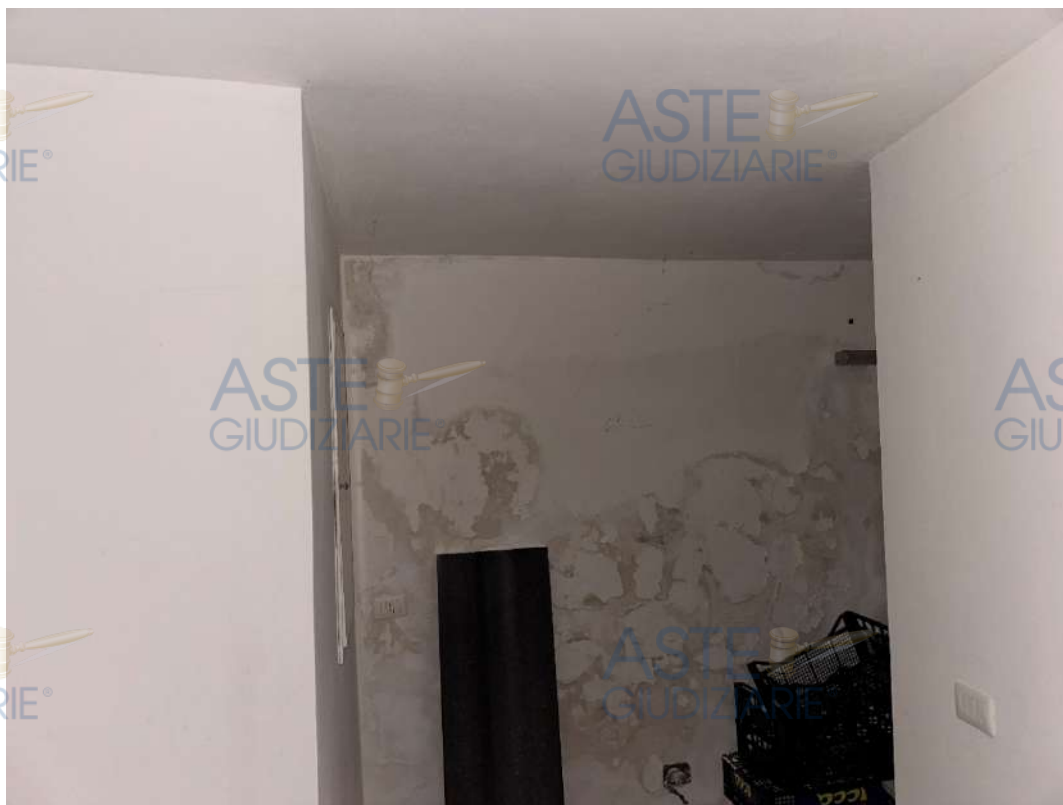
10) FOTO: INTERNO DEL PIANO INTERRATO DELL'IMMOBILE PIGNORATO
