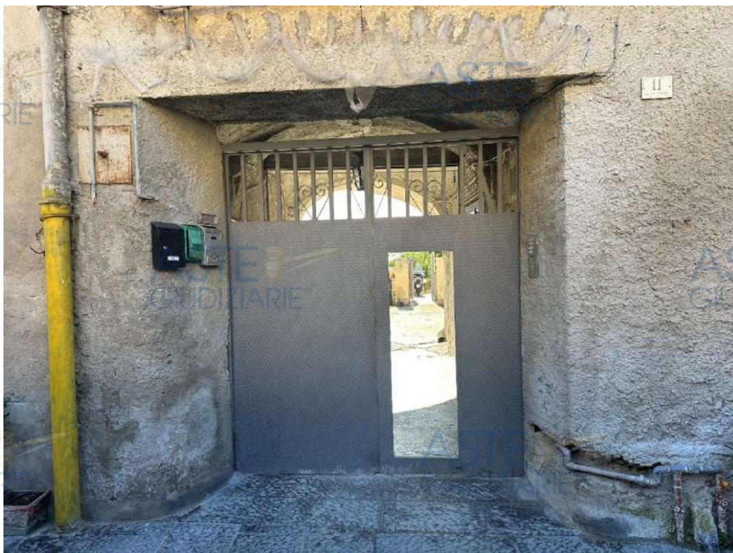
4) FOTO: INGRESSO PRINCIPALE CON PORTONE IN FERRO PER ACCEDERE ALL' ANDRONE
