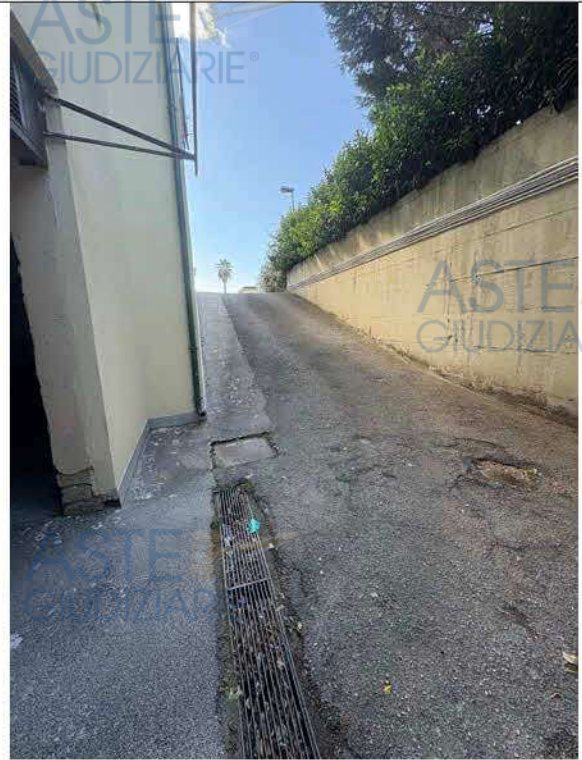
Fotografia n. 4 _ Rampa comune di ingresso al piano interrato
