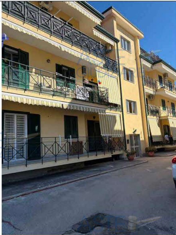
Fotografia n. 1 _ Prospetto del fabbricato sull'area comune
