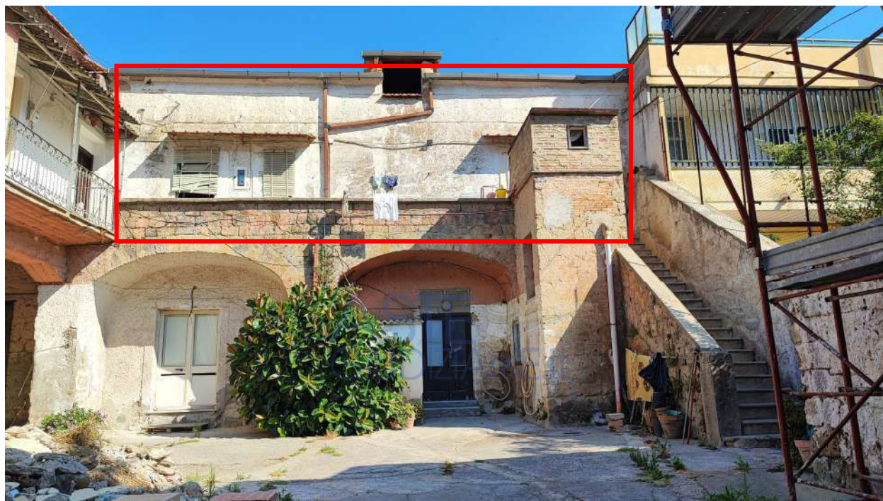
Prospetto del fabbricato
