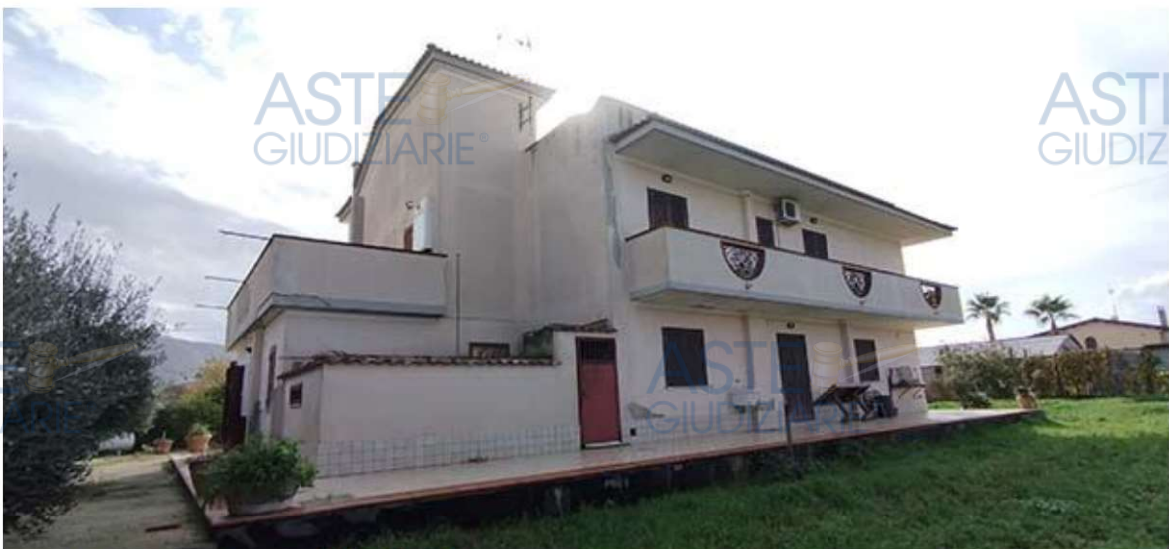
imm2.09: vista posteriore del fabbricato
