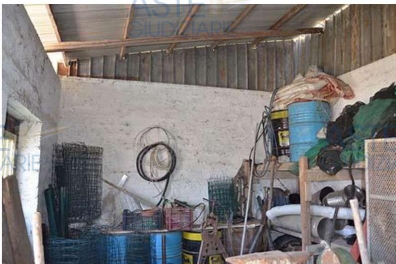
imm2.49: interno del manufatto
