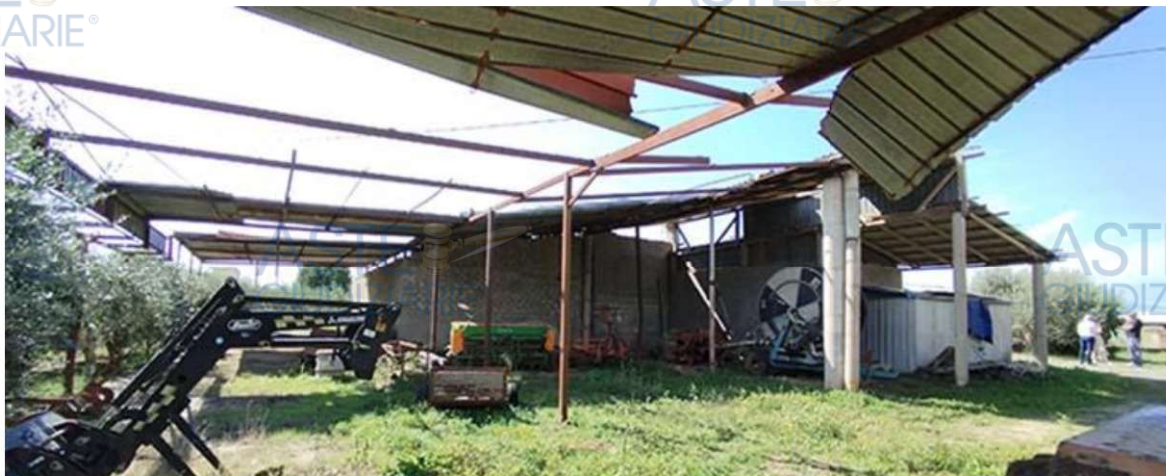
imm2.50: tettoia esterna
