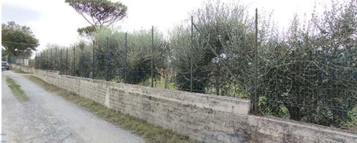
imm2.58: confine del terreno sul lato di ingresso
