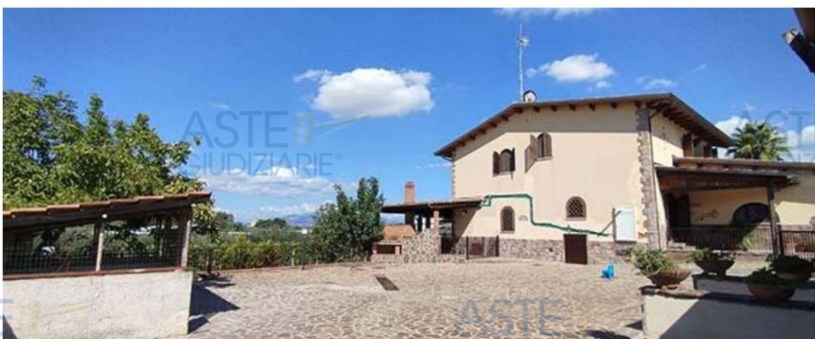
imm2.18: vista dal cortile esterno
