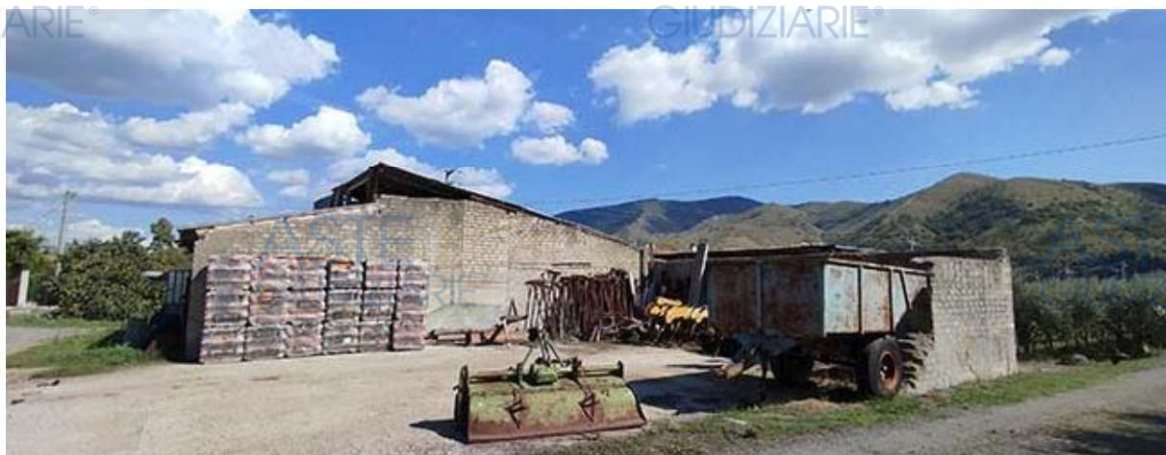
imm2.52: area di risulta tettoia rimossa
