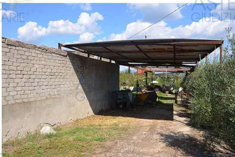
imm2.51: tettoia esterna (lato posteriore)
