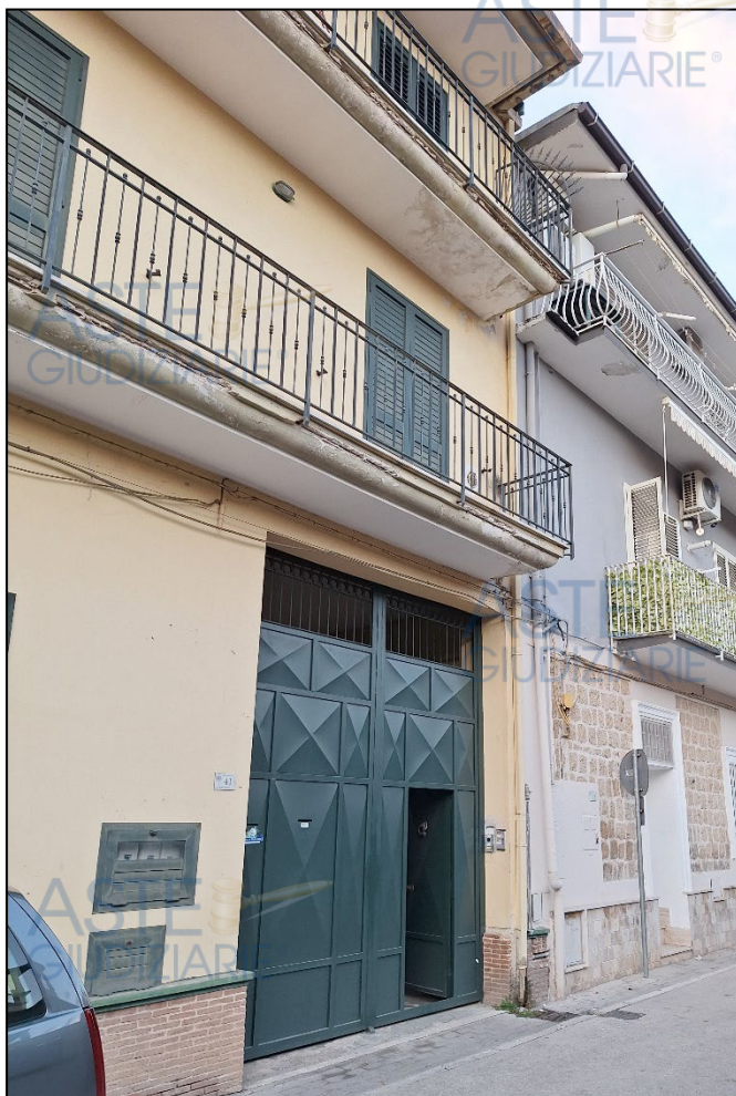
Foto. 1 – Accesso al fabbricato in via San Francesco 41
