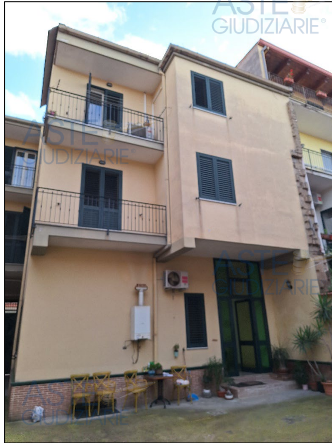
Foto. 3 – Prospetto Nord sulla corte comune
