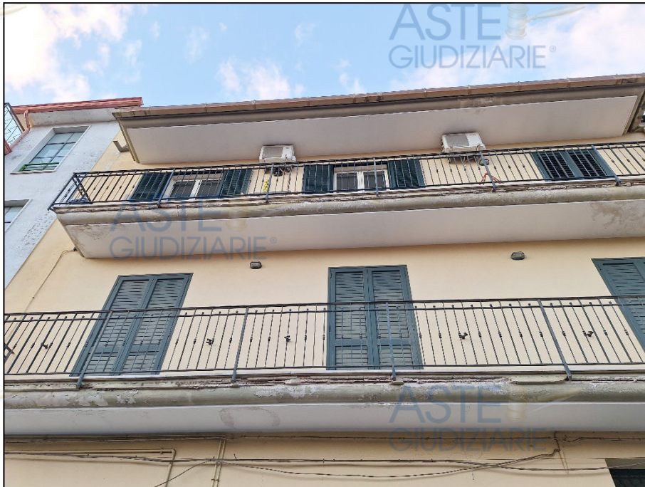
Foto. 2 – Prospetto Sud su via San Francesco
