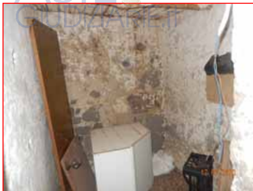
Foto n. 3 – interno locale di sgombero
