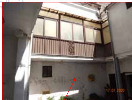
Foto n. 2 - area scoperta "portico"
