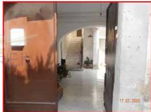
Foto n. 2 – Ingresso da Vico II° Murillo
