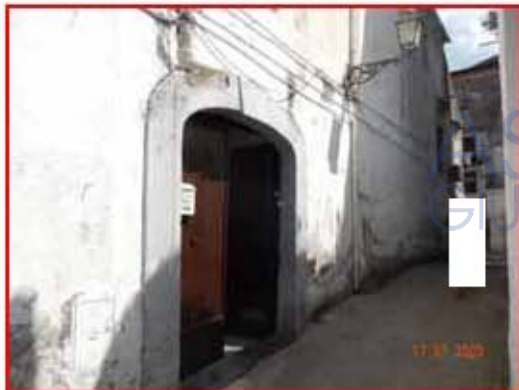
Foto n. 1 – Ingresso da Vico II° Murillo
