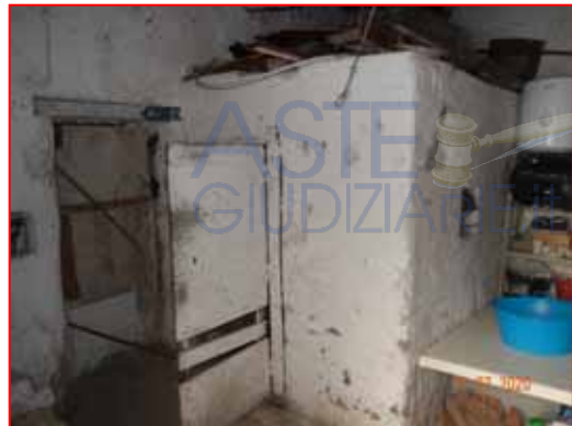
Foto n. 2 – locale di sgombero
