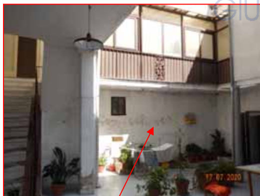
Foto n. 1 - area scoperta "portico"
