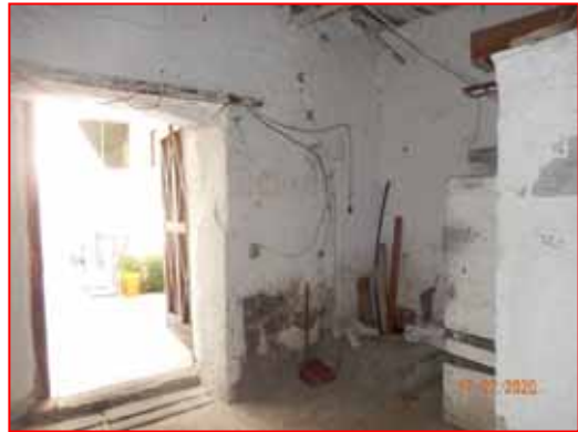
Foto n. 4 – locale di sgombero
