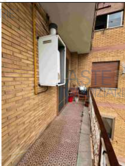
Balcone su cortile interno
