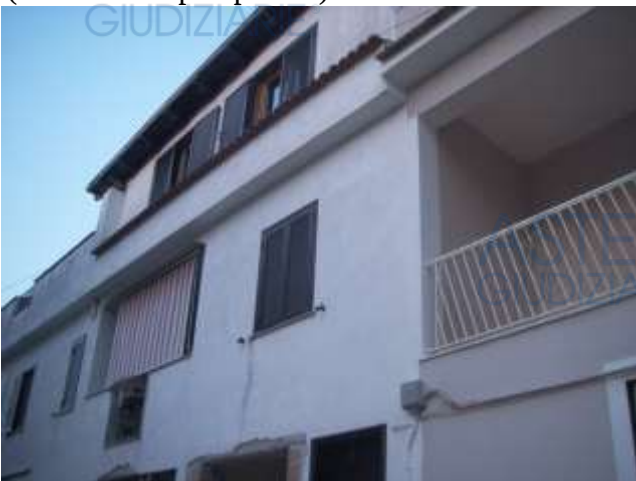
(foto 4: prospetto su via Manzoni)
