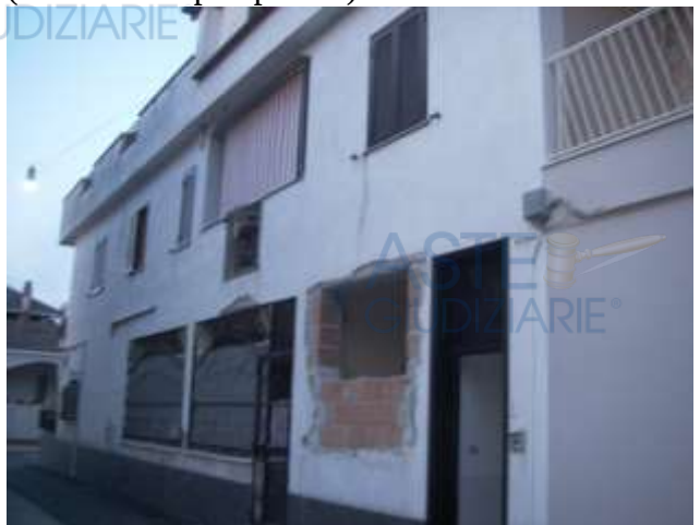
(foto 3: prospetto su via Manzoni)
