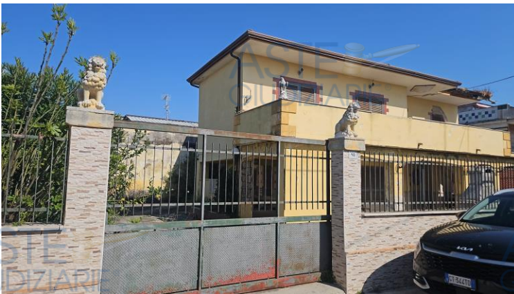
Viale D'Orta-Ingresso carrabile
