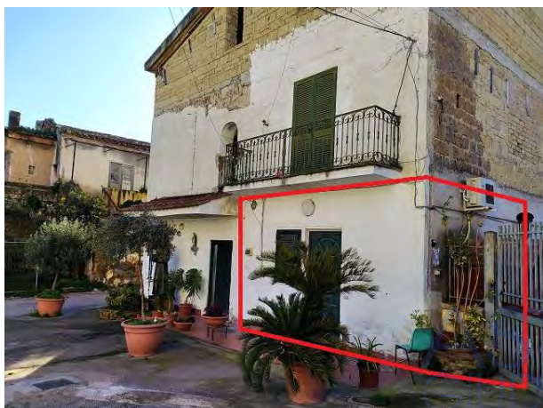
Porta di ingresso lato Nord
