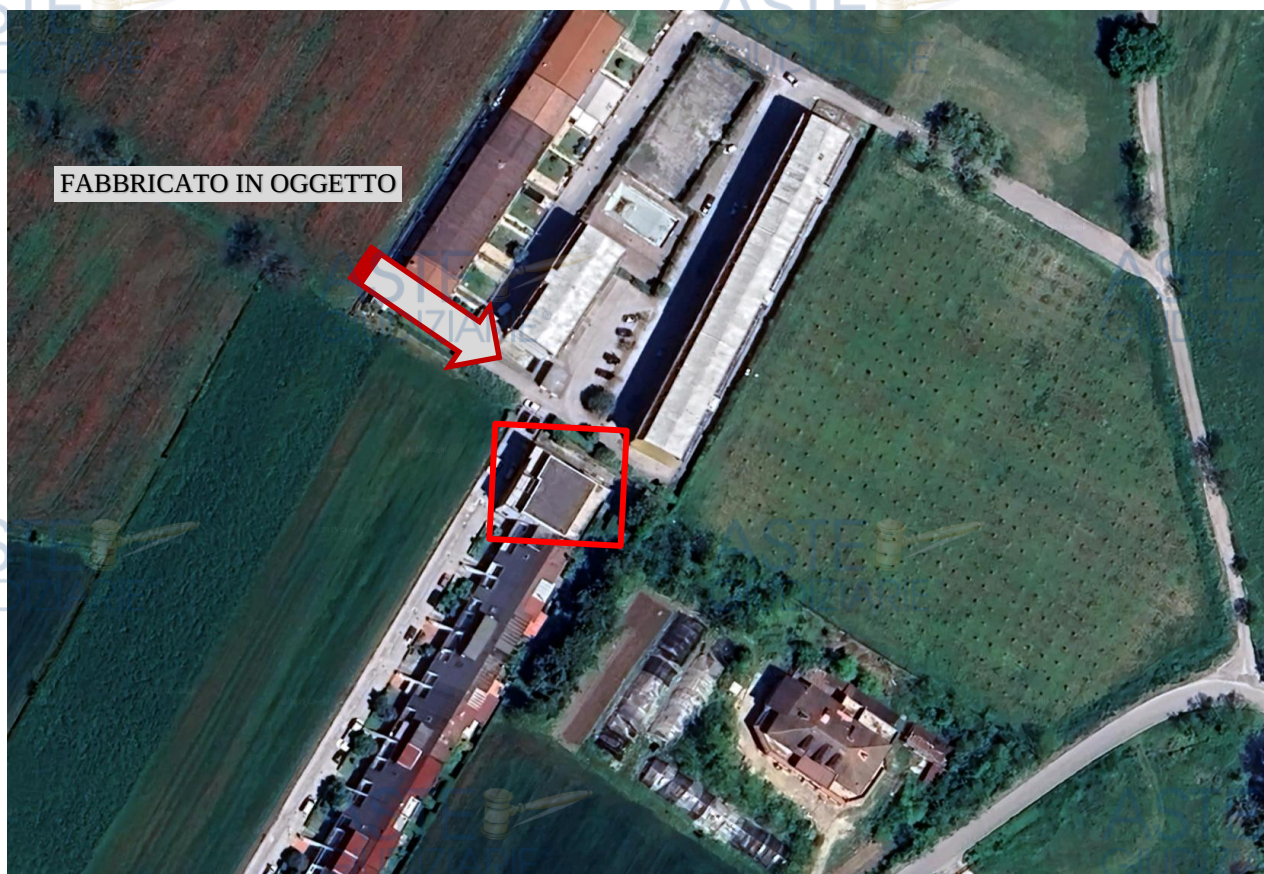
Figura 1 - Foto Satellitare con indicazione fabbricato in oggetto
