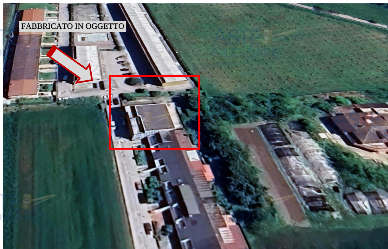
Figura 2 – Foto satellitare con indicazione fabbricato in oggetto
