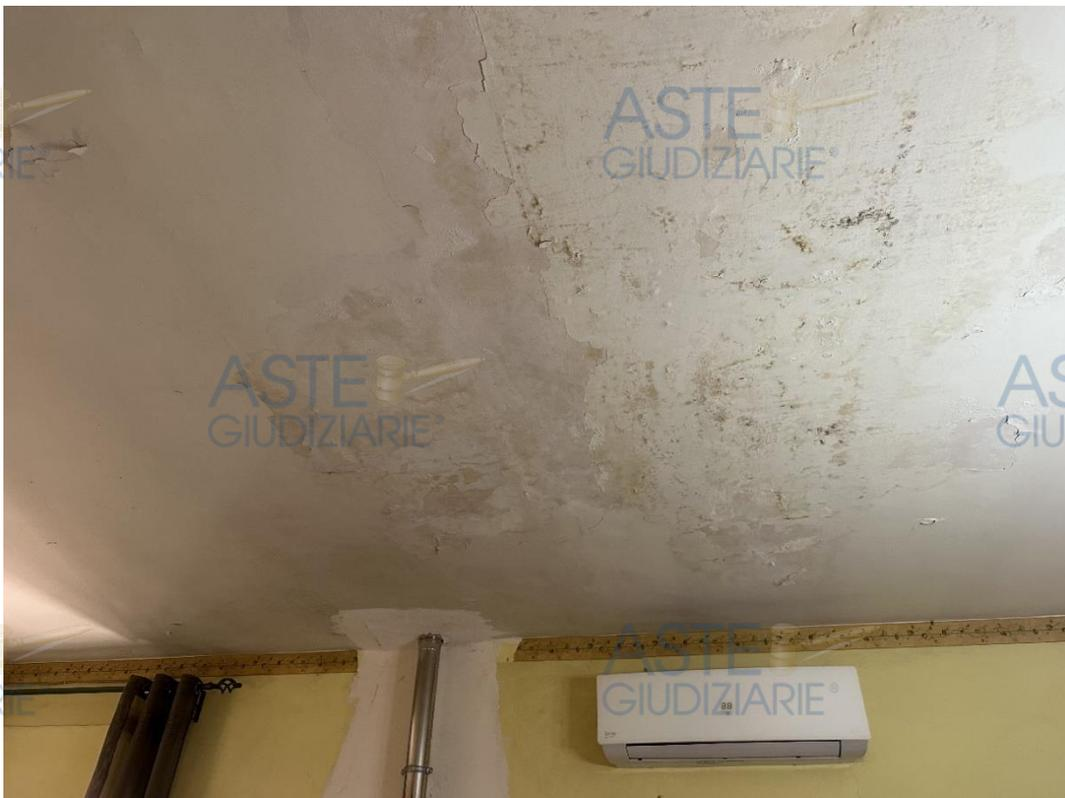
**FOTO: PARTICOLARE DELLE MACCHIE DI MUFFA VERDE SUL SOFFITTO DEL VANO SOGGIORN N°1**
