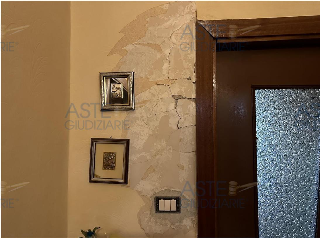
**FOTO: PARTICOLARE DELLE DISTACCO DELL'INTONACO SULLA PARETE DEL VANO DISIMPEGNO**
