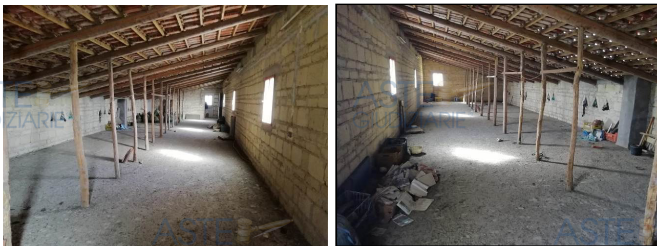
Vista interna del locale sottotetto
