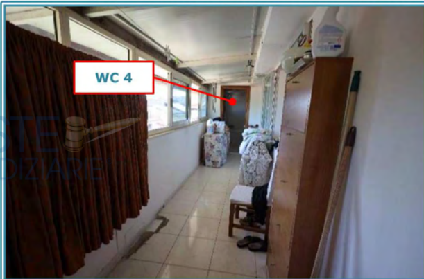
Figura 29 Veranda (Piano Secondo - Sottotetto)
