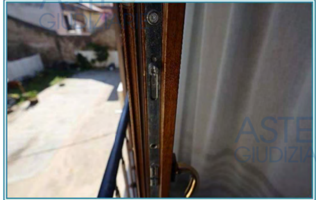
Figura 26 Dettaglio dei serramenti
