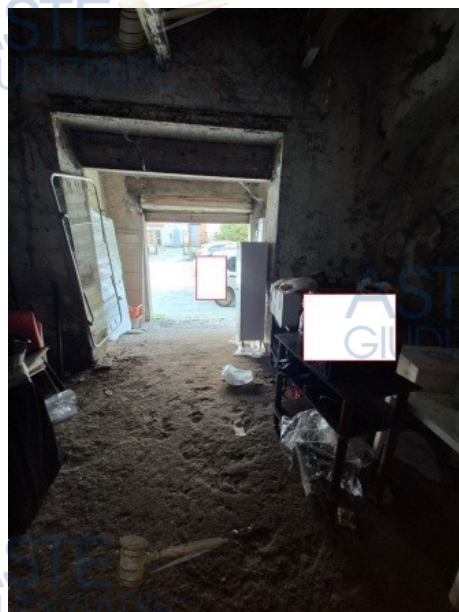
Figura 11 interno del deposito
