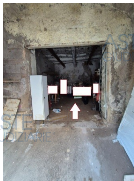
Figura 9 parte anteriore del deposito (ex porticato)
