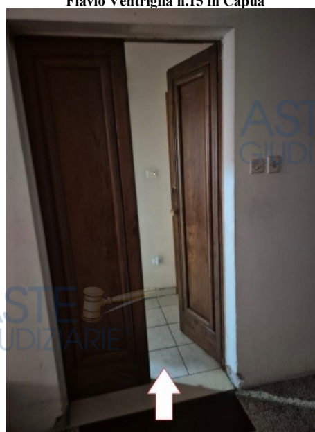
Figura 9 accesso all'appartamento al piano rialzato
