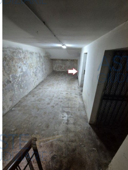
Figura 19 vano comune con accesso alla cantinola al piano seminterrato
