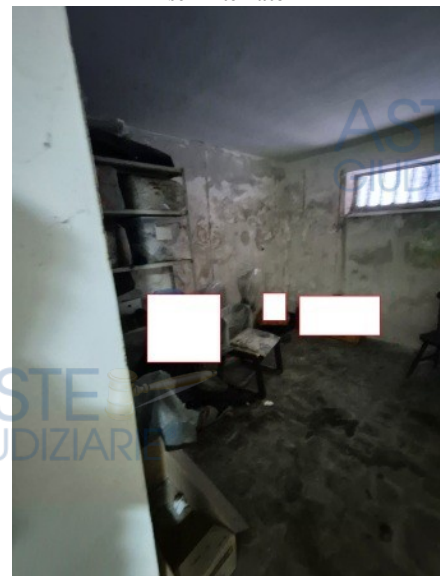
Figura 21 cantinola al piano seminterrato
