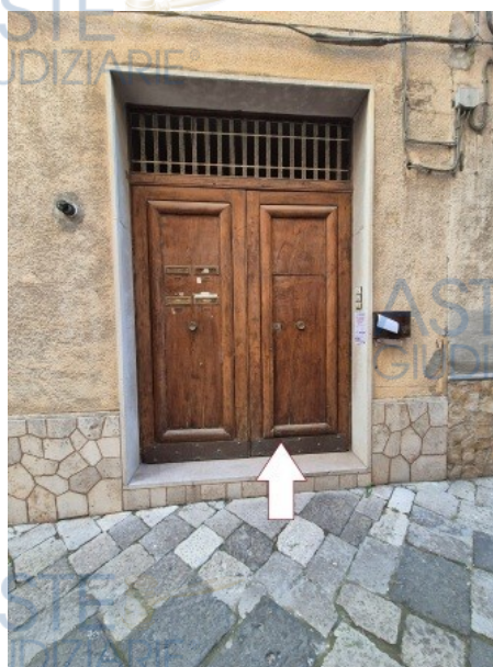
Figura 7 portone di accesso al vano scala comune dal vico Flavio Ventriglia n.15 in Capua
