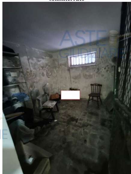
Figura 20 cantinola al piano seminterrato
