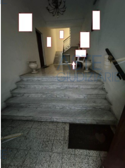
Figura 18 vano scala comune con accesso al piano seminterrato
