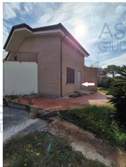
Figura 37 cortile pertinenziale al piano terra
