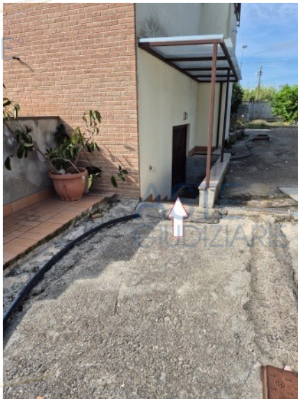
Figura 32 accesso al piano seminterrato dalla scala esterna
