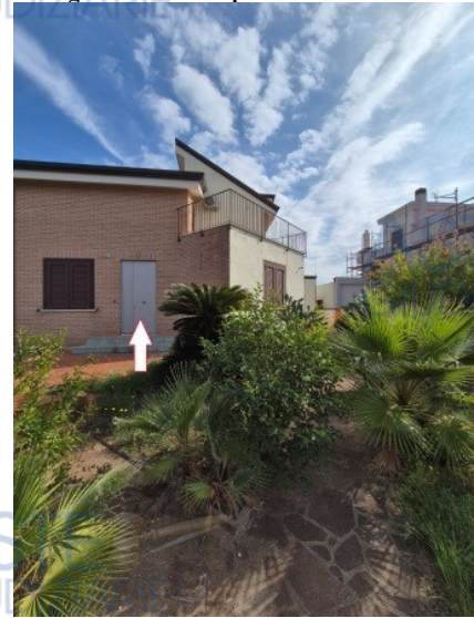
Figura 43 terreno pertinenziale lato sud
