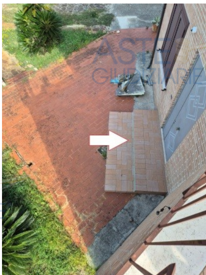
Figura 36 cortile pertinenziale al piano terra
