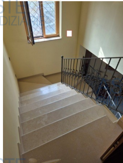
Figura 21 scala interna di collegamento tra il piano terra ed il primo piano
