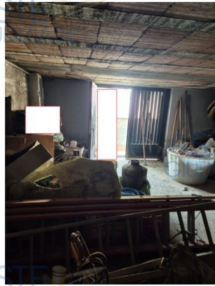
Figura 33 cantinola 2 piano seminterrato
