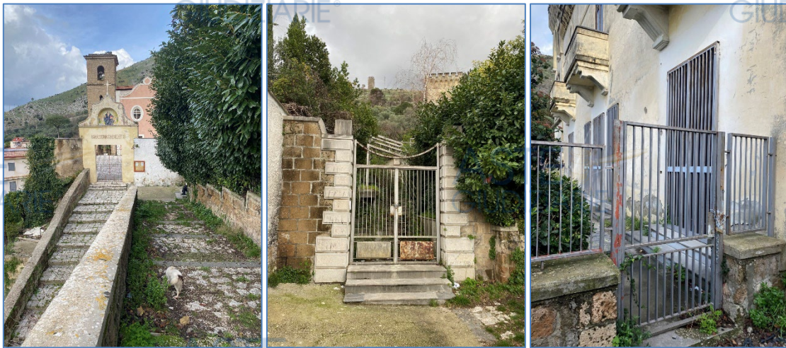
Figura 6. Da sinistra a destra: gradinata di via San Benedetto, ingresso ovest, ingresso sud.
