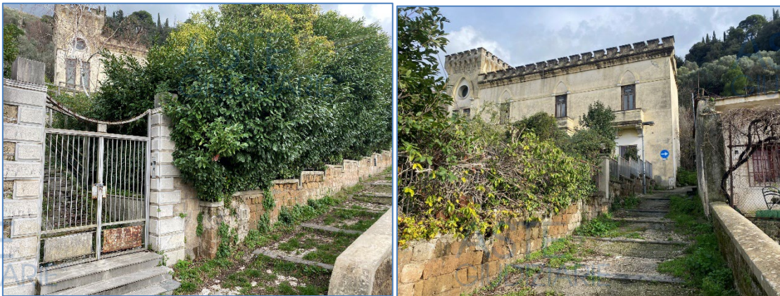
Figura 3. Accessi alla Villa Santamaria da ovest e da sud.
