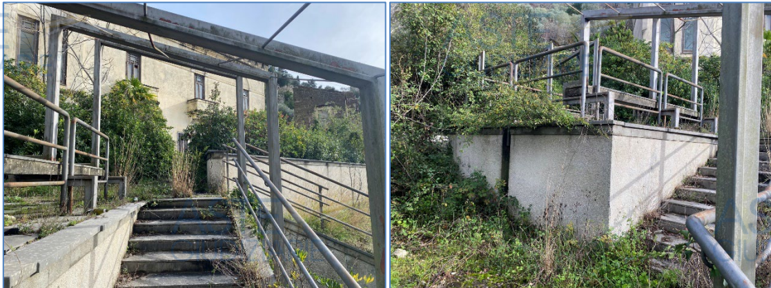
Figura 8. Scala e struttura di accesso da ingresso ovest.
