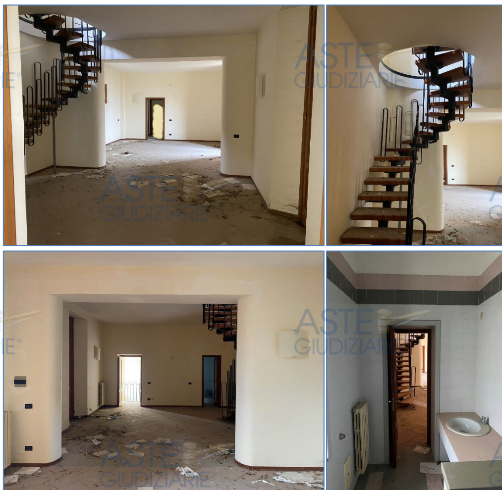
Figura 12. Locali piano primo (cfr. allegato C-1).
