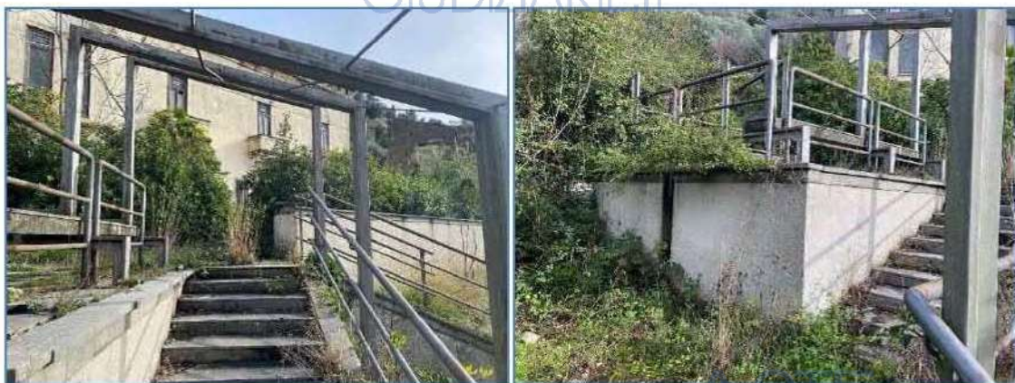
Figura 8. Scala e struttura di accesso da ingresso ovest.
