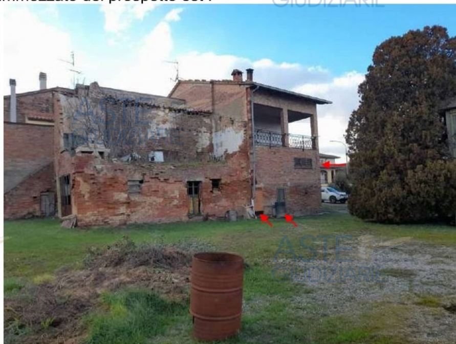
Stato attuale lato est
