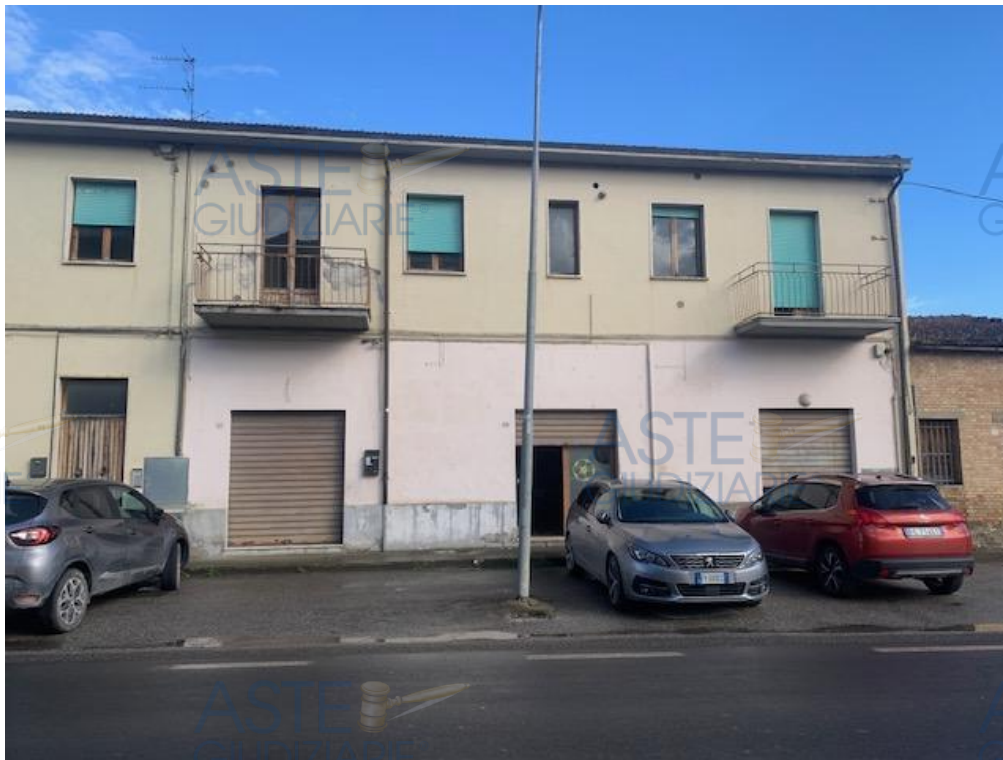
Vista esterna fabbricato nc.17
