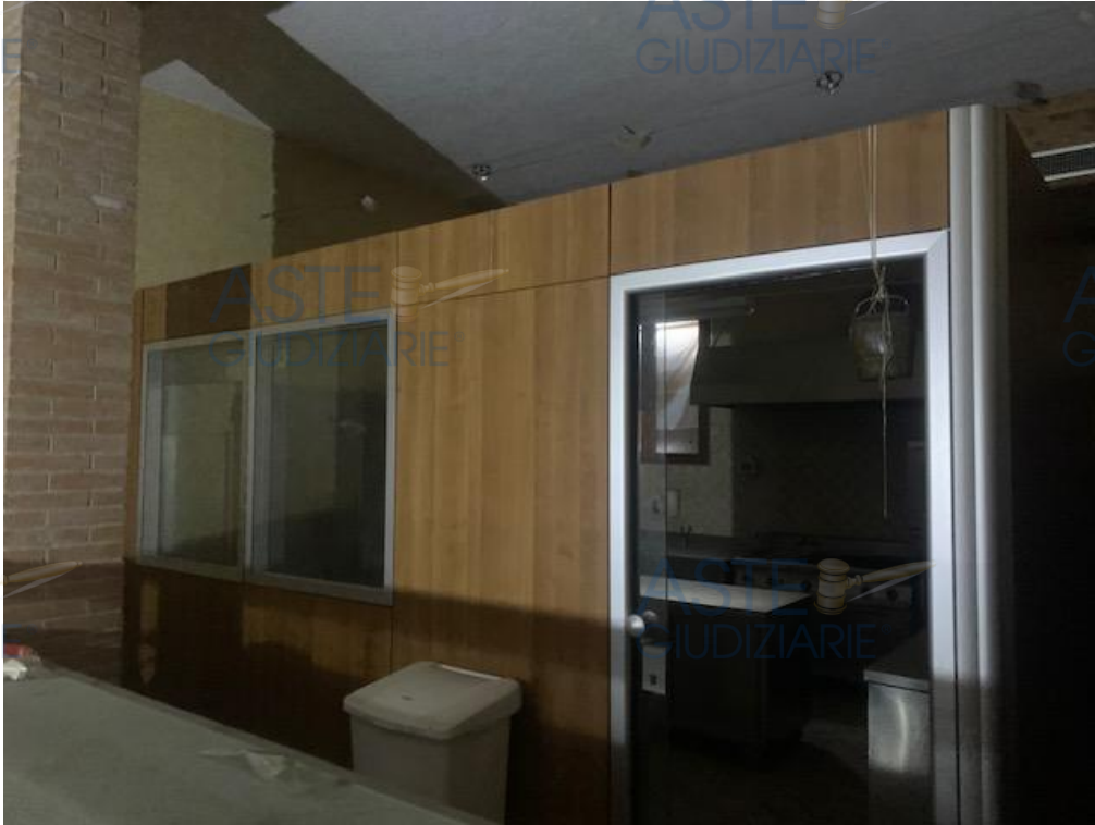
Vista interna sub 17
