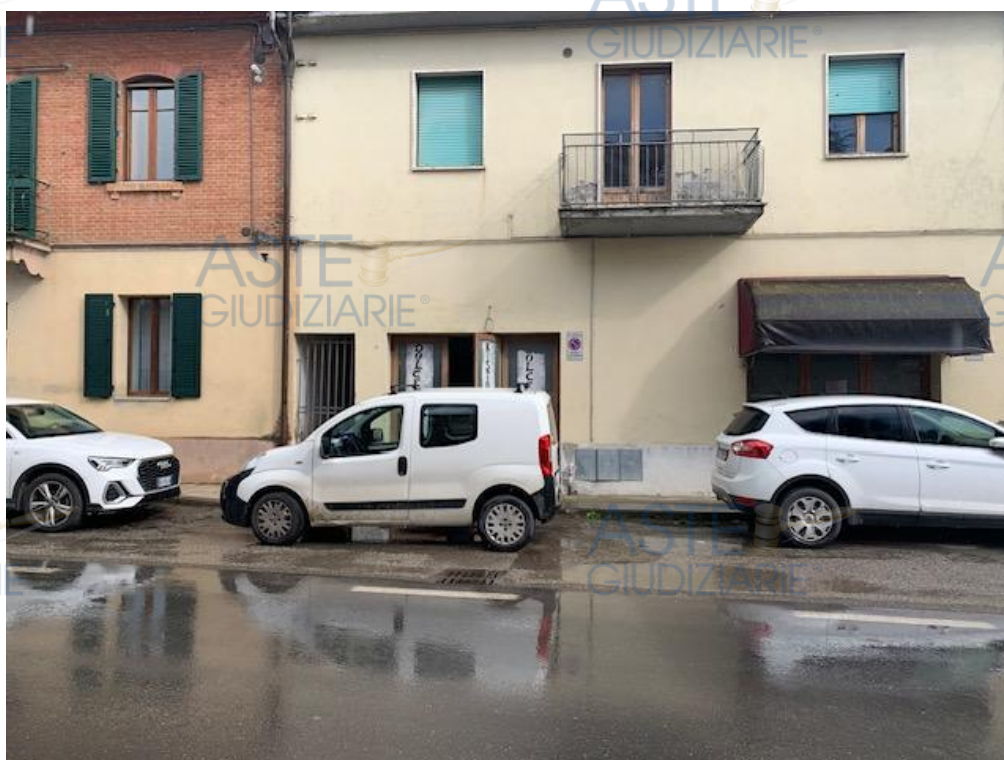
Vista esterna fabbricato da Via Del Taja
