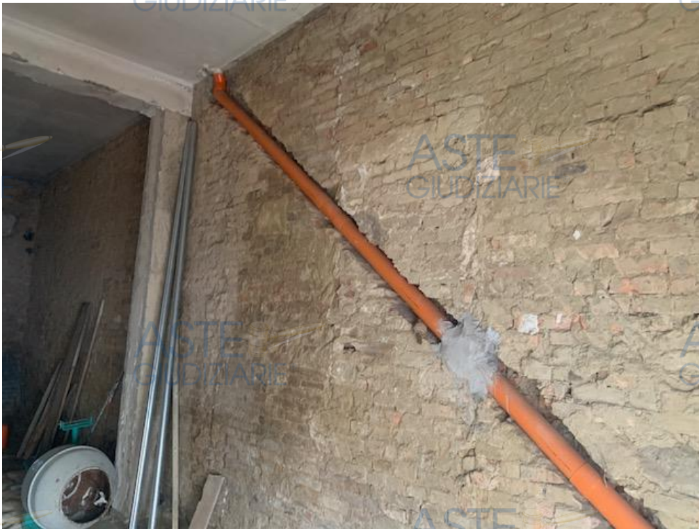
Vista interna porzione sub 5 e subb 7 e 8
