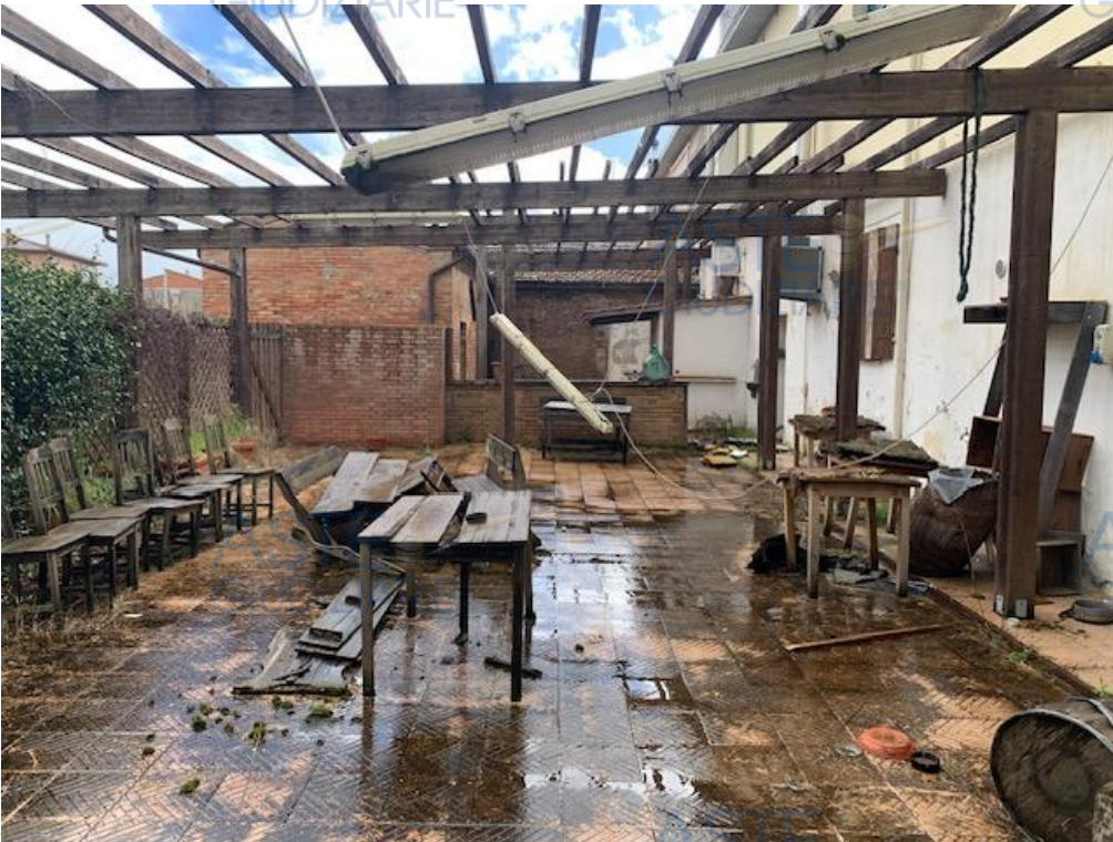
Vista resede sub 37
