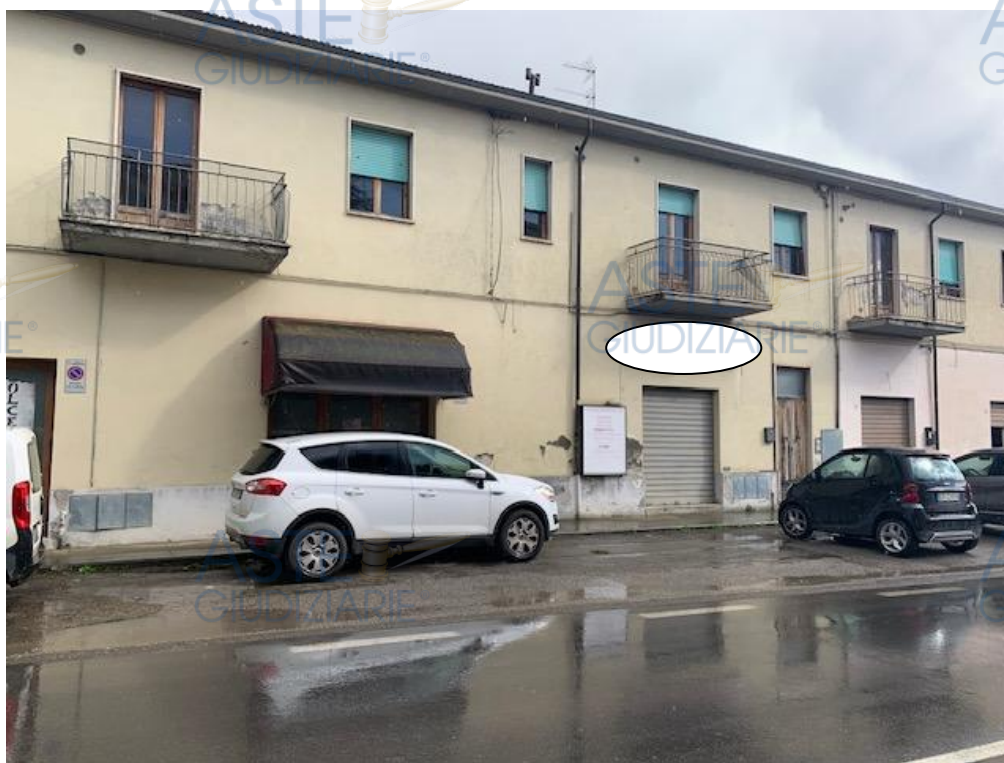
Vista esterna fabbricato da Via Del Taja
