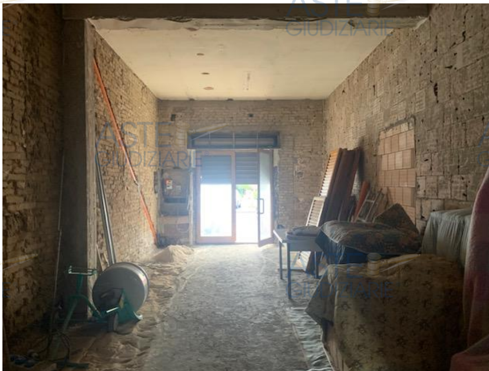
Vista interna porzione sub 5 e subb 7 e 8
