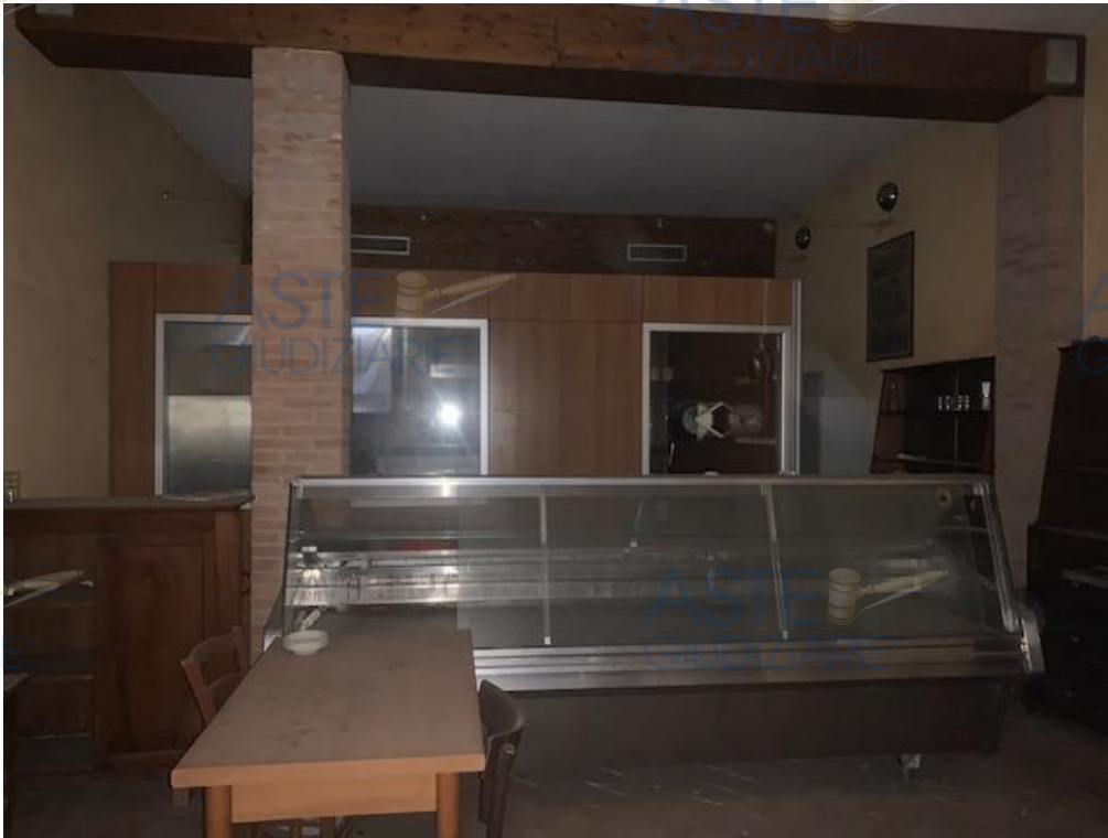
Vista interna sub 17
