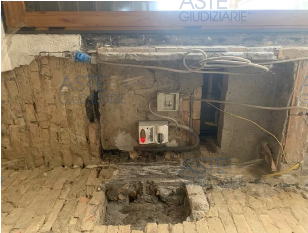
Vista interna porzione sub 5 e subb 7 e 8
