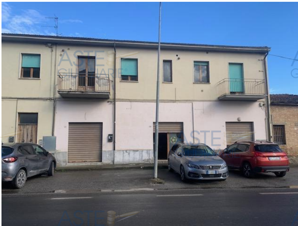
Vista esterna ingresso nc.19-21 subb 4-5
