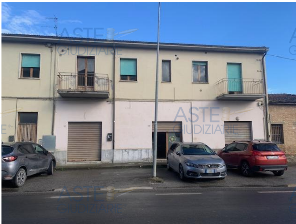
Vista esterna fabbricato da Via Del Taja
