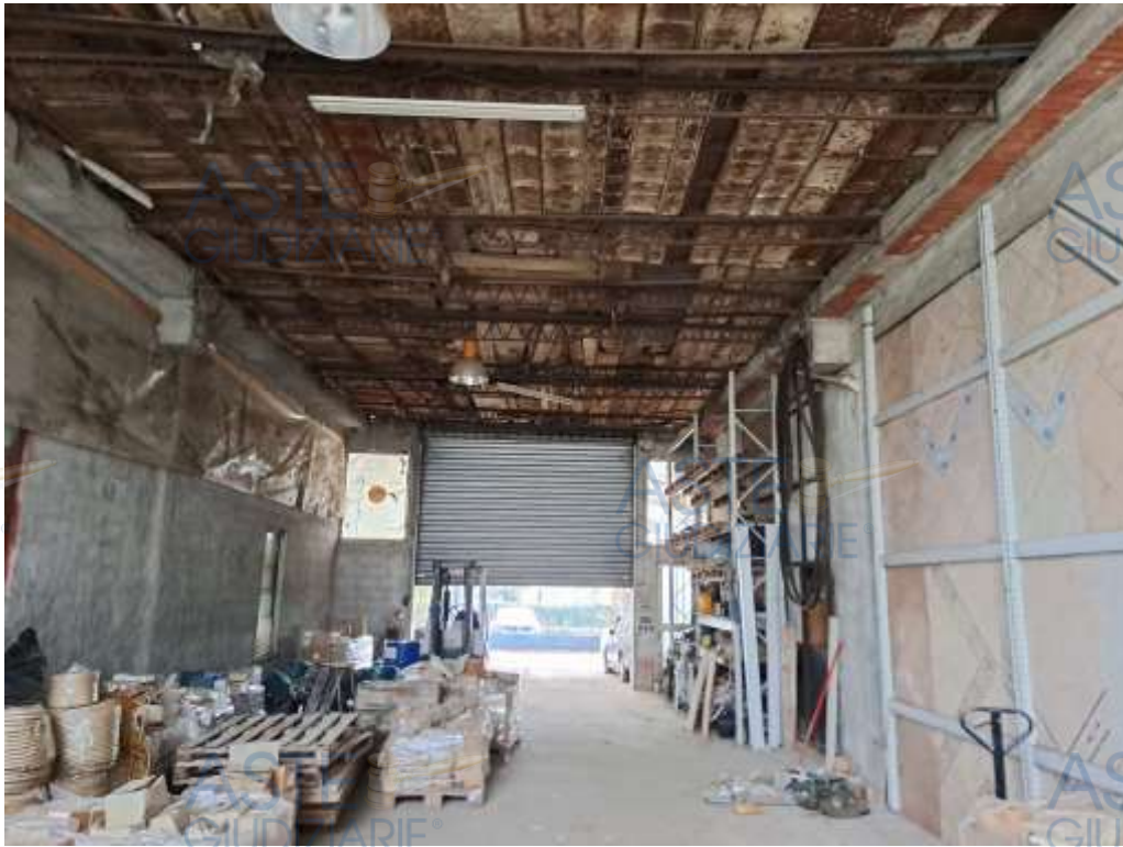
Fig. 20_ Foto interna manufatto_Corpo 1_sottopassaggio P.T.
