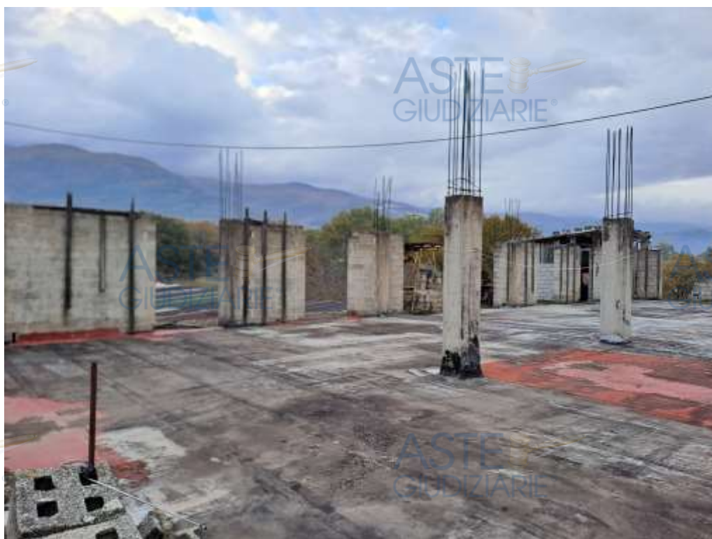
Fig. 27_ Foto interna manufatto_Corpo 10_lastrico solare P.2
