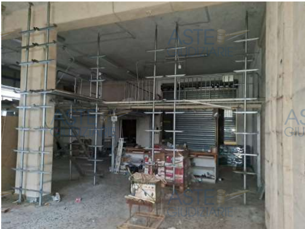
Fig. 21_ Foto interna manufatto_Corpo 1_locale commerciale P.T.
