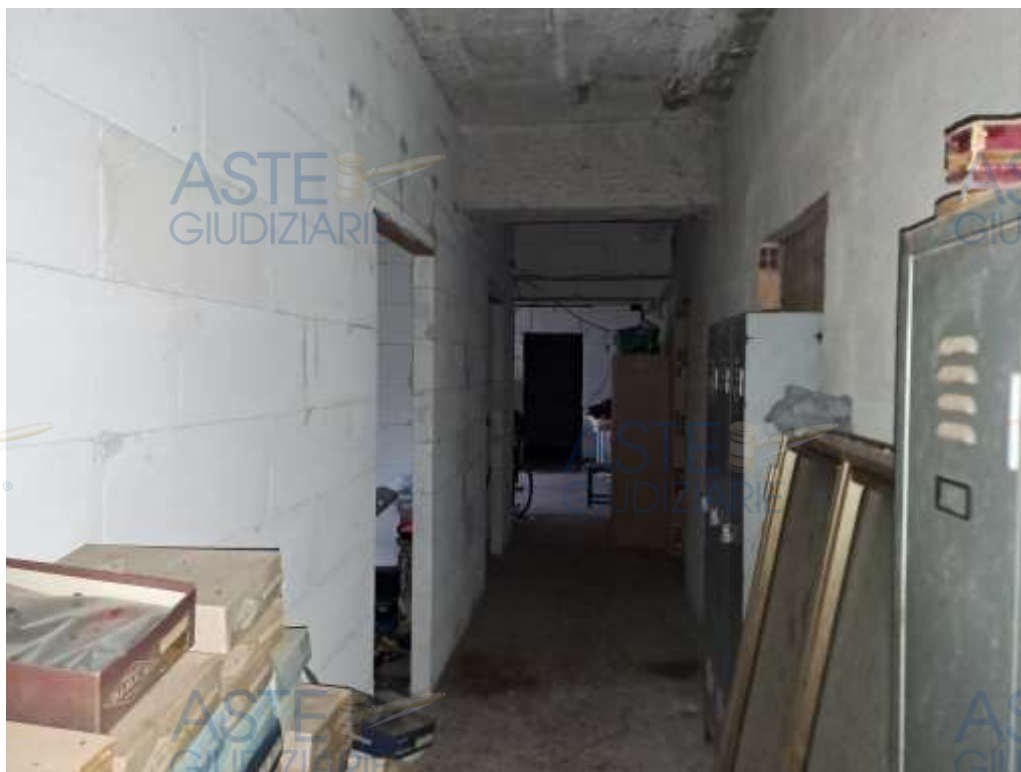
Fig. 24_ Foto interna manufatto_Corpo 9_unità in corso di costruzione P.1
