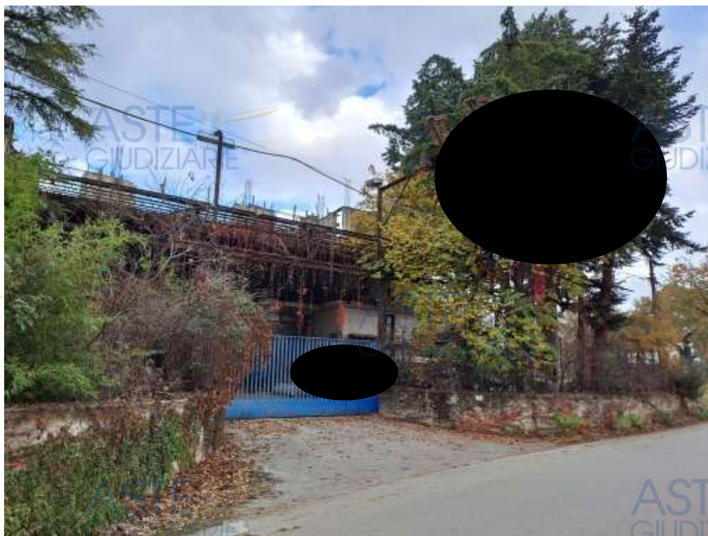
Fig. 8_Foto ingresso da via Palazzuolo Spinito
