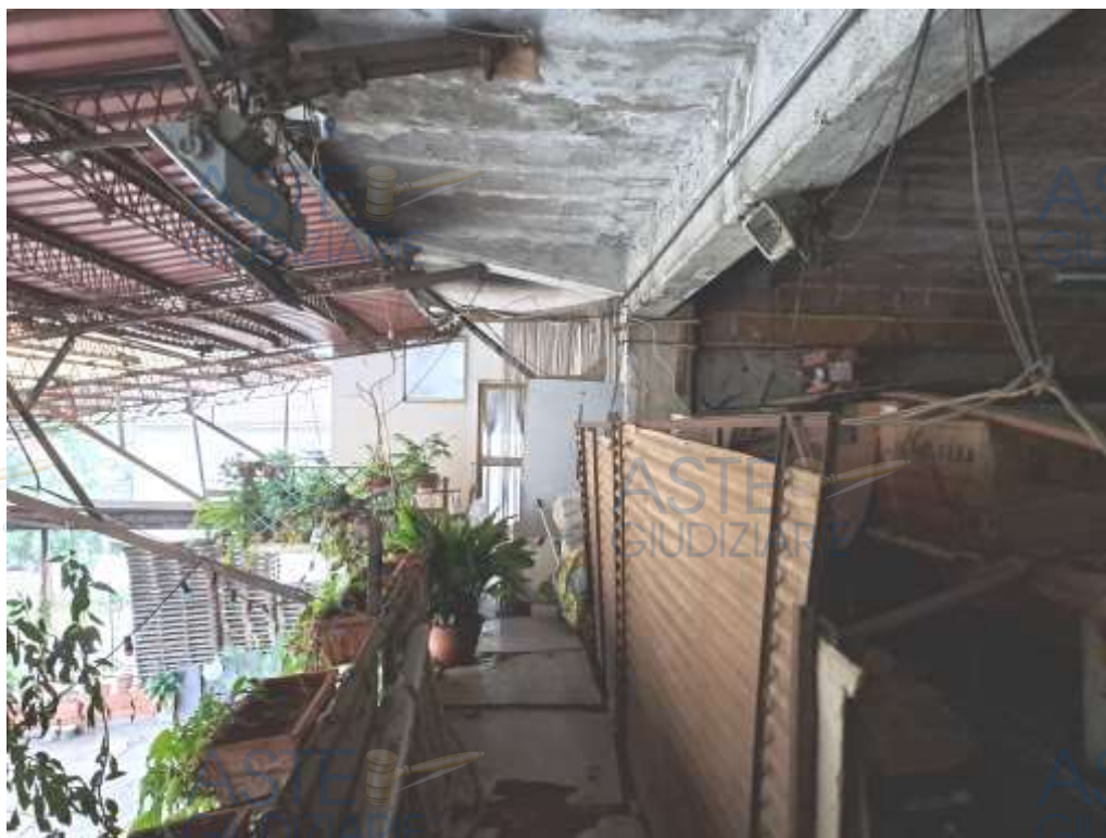
Fig. 26_ Foto interna manufatto_Corpo 8-9_soppalco realizzato tra i due corpi_ P.1
