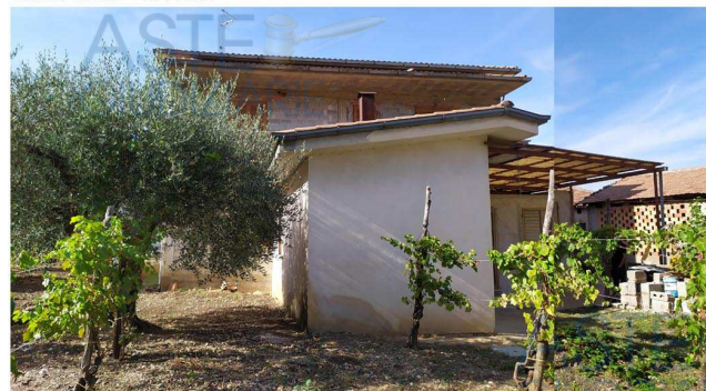
vista SUD - EST
