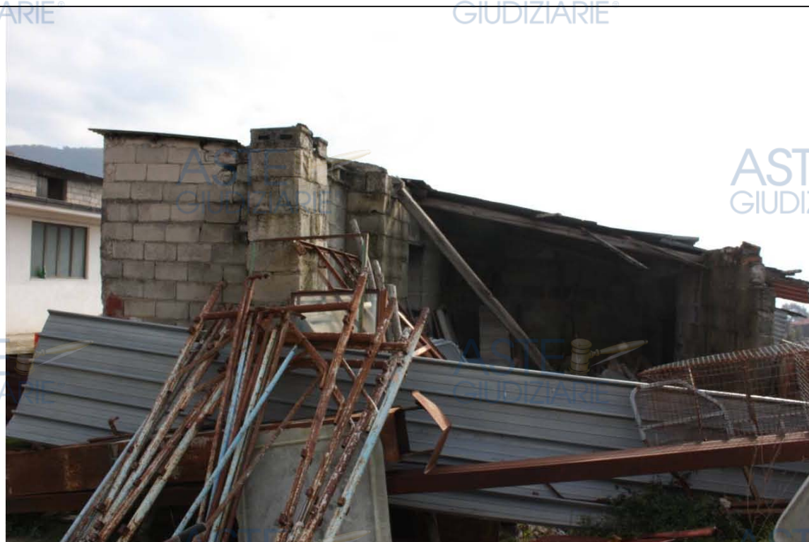
Foto n. 8_Ampliamenti al Corpo "B"
