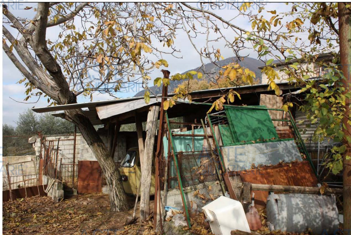
Foto n. 9_Ampliamenti al Corpo "B"
