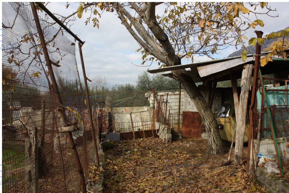
Foto n. 10_Ampliamenti al Corpo "B"
