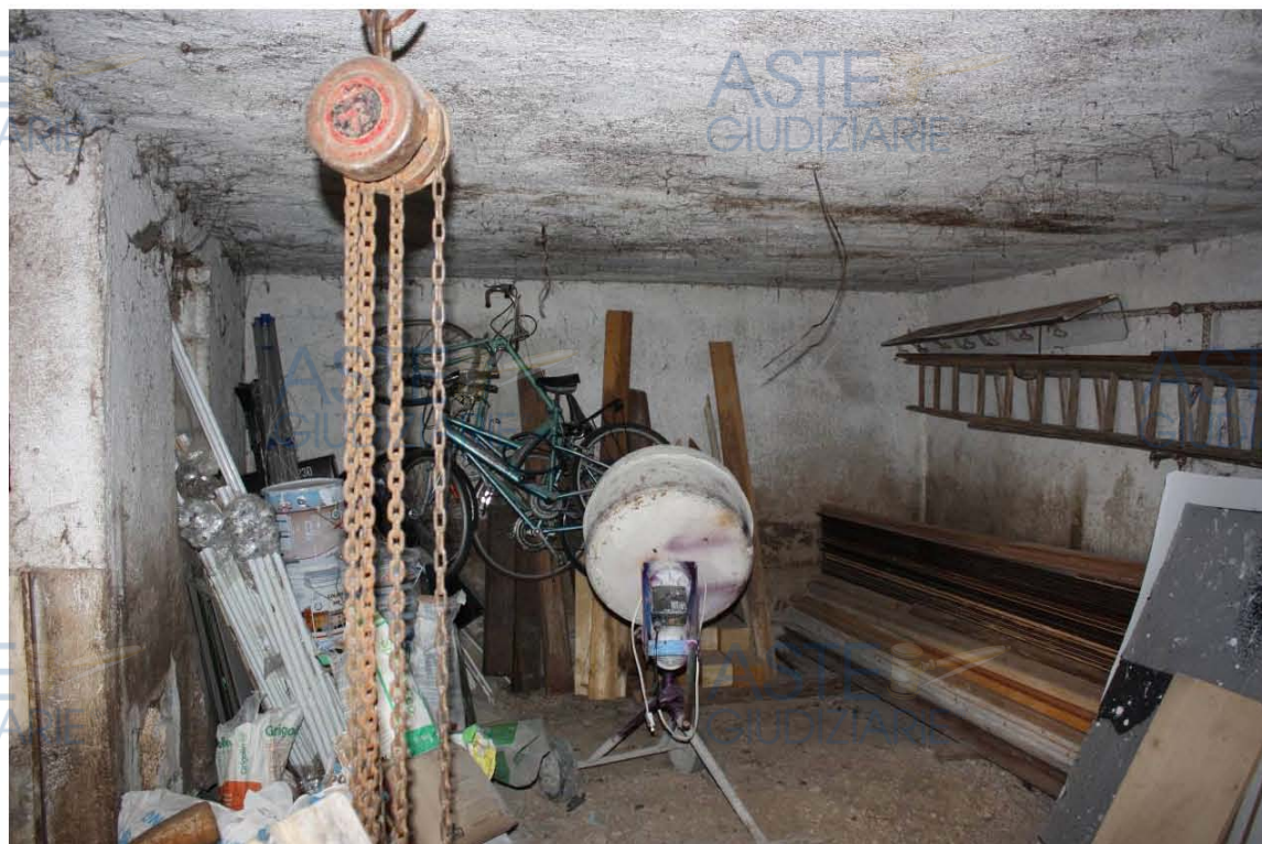
Foto n. 3_Corpo "A" _Corpo non più diviso in box (come da Licenza edilizia rilasciata)
