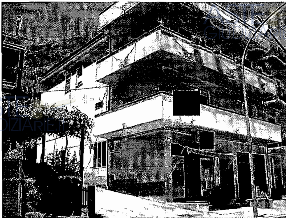
FOTO N. 1 – fabbricato in via Vincenzo Marone
