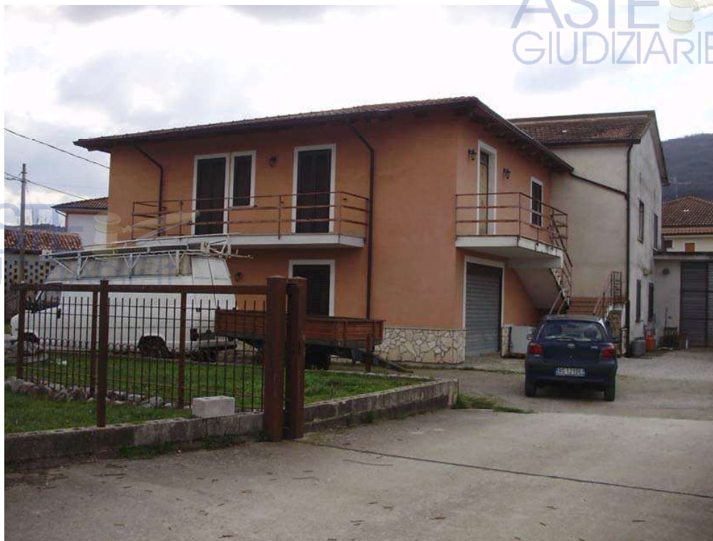
Foto n. 1 – fabbricato con corte
