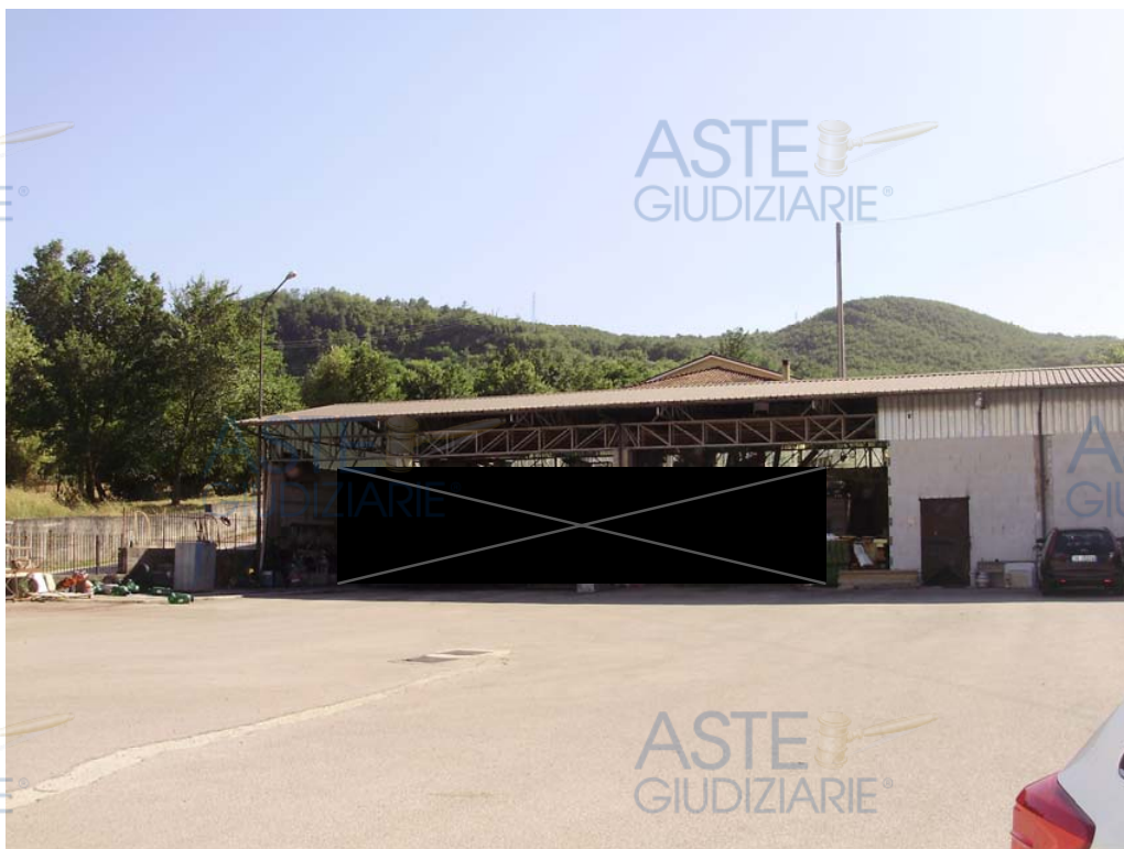
Foto n. 10 – capannone abusivo costruito sulle p.lle 513, 695 e 714
