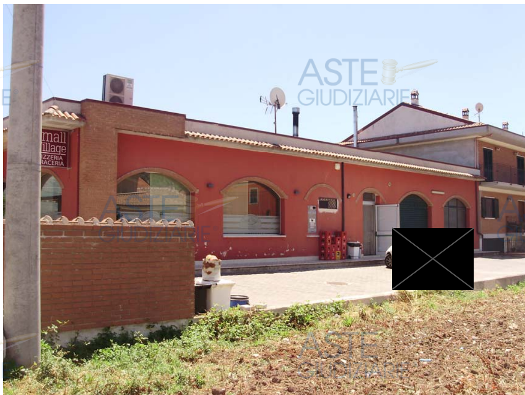
Foto n. 1 – prospetto ovest e accesso al locale
