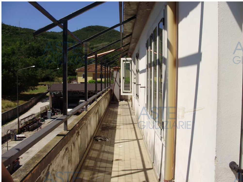
Foto n. 9 – terrazza al secondo piano
