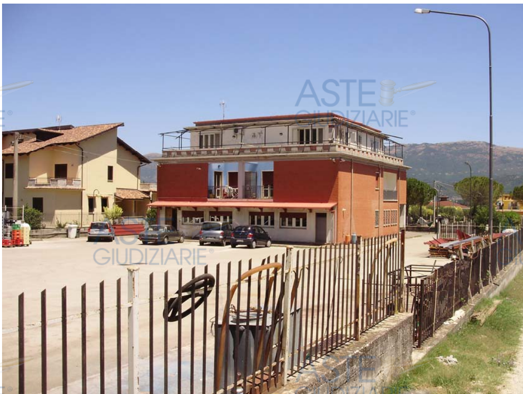
Foto n. 2 – prospetto sud ovest
