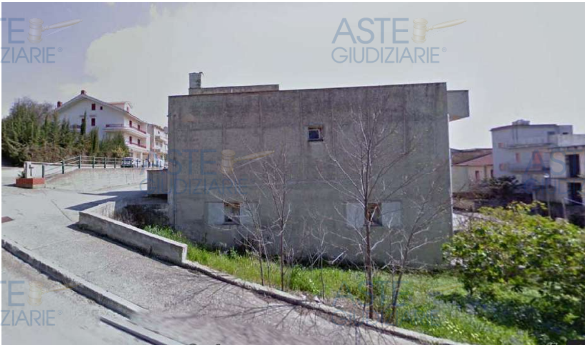
Fronte laterale, prospiciente Via G. Garibaldi (foto da Google Maps)
