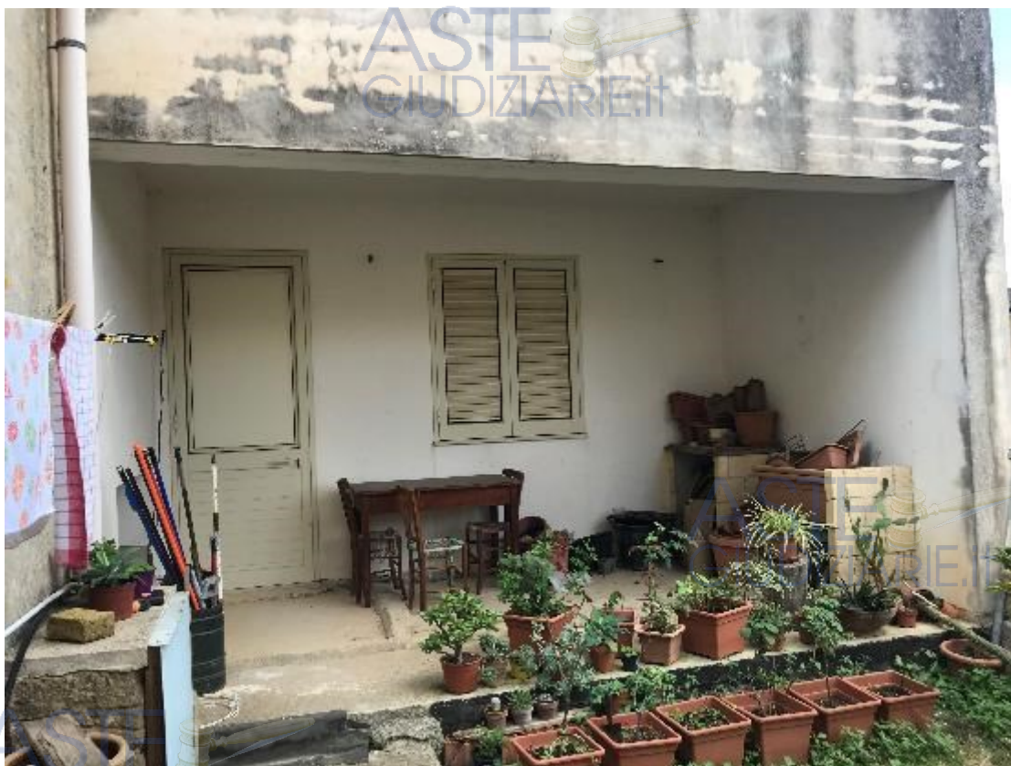
Foto 2.4 – Particolare del prospetto del fabbricato – Lato Nord
