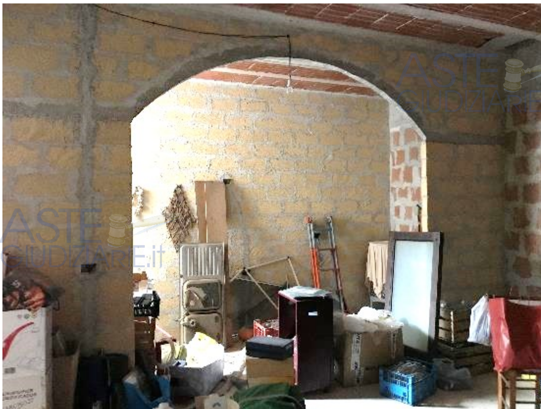
Foto 2.20 – Angolo cottura dell'abitazione
