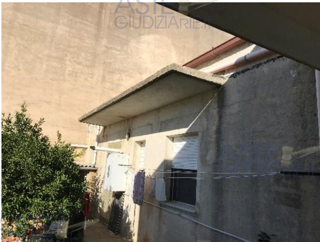
Foto 1.4 – Particolare del prospetto del fabbricato – Lato Ovest
