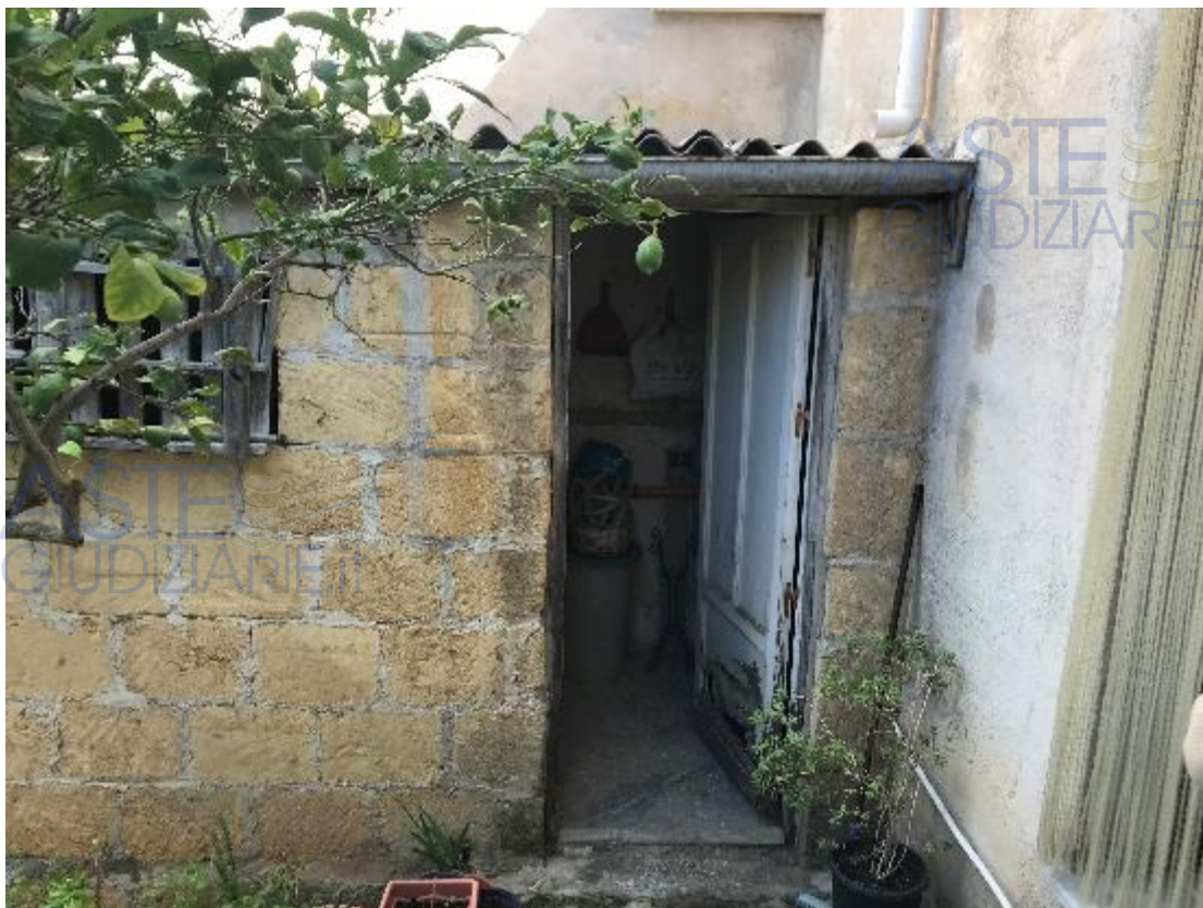
Foto 1.20 – Particolare della porta di accesso del ripostiglio
