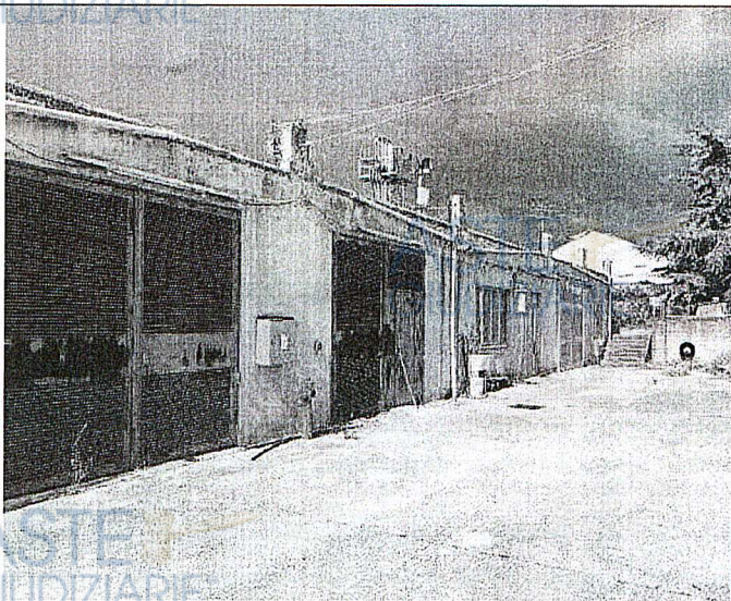
Foto n.5 – Vista della centrale termica e della zona uffici
