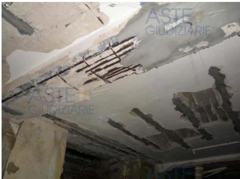
*Immagine n.9: foto di dettaglio di alcuni delle travi e solai danneggiati*
