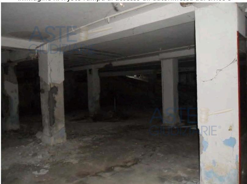
Immagine n.5: foto interno autorimessa con evidenze dei pilastri ammalorati
