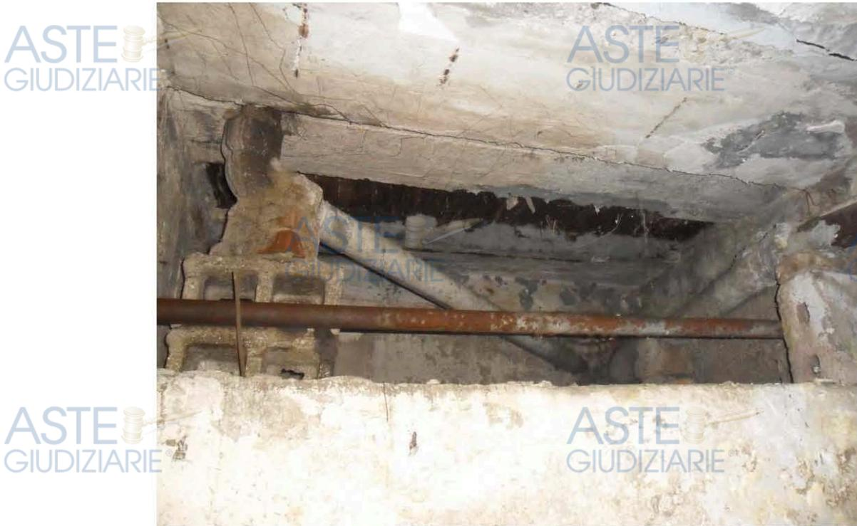
Foto n.12: dettaglio su una delle bocche di lupo della autorimessa con griglia di areazione cementata e carenze delle tubazioni di scarico condominiali
