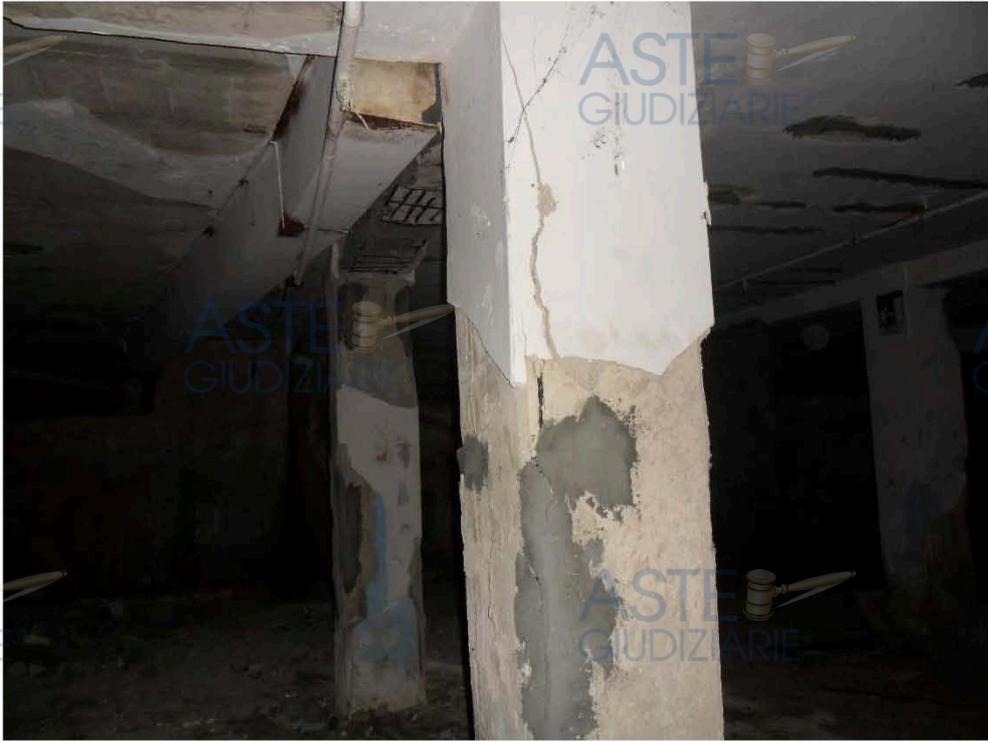
Foto n.10: dettaglio parte di pilastri e travi danneggiate nell'autorimessa
