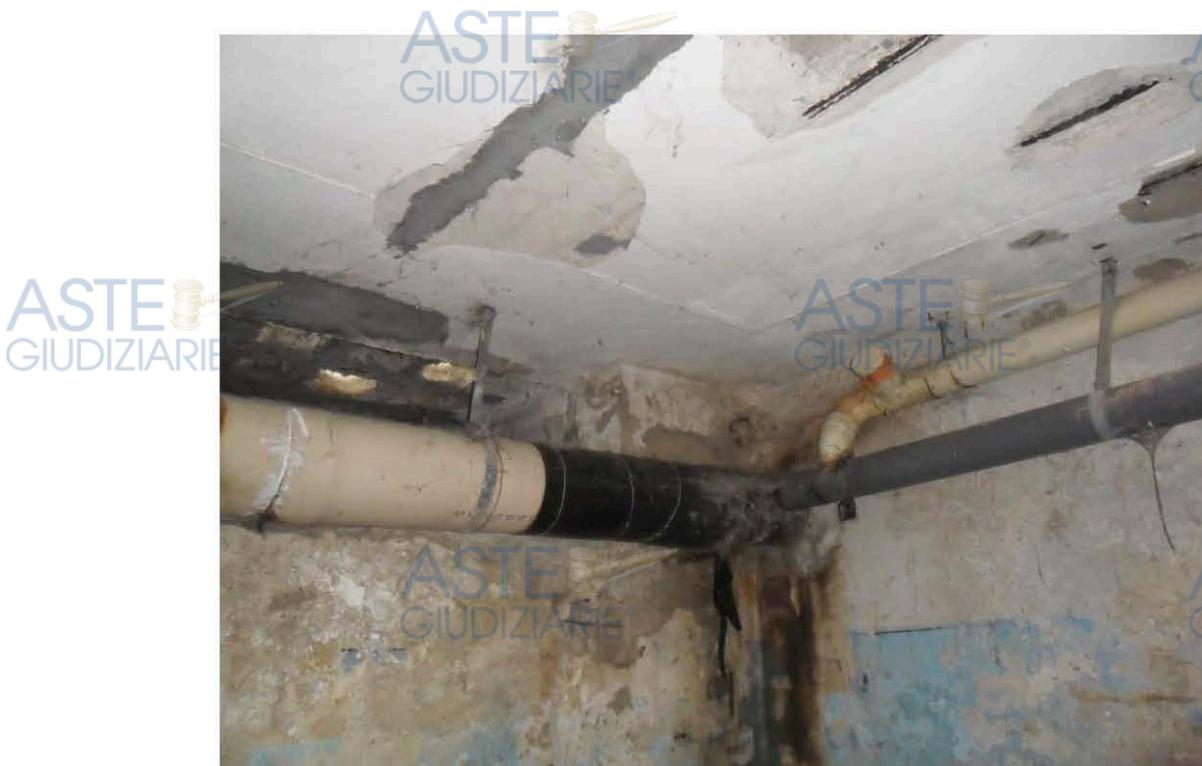
Foto n.13: dettaglio di ulteriori carenze delle tubazioni di scarico condominiali poste sui succelli dell' autorimessa
