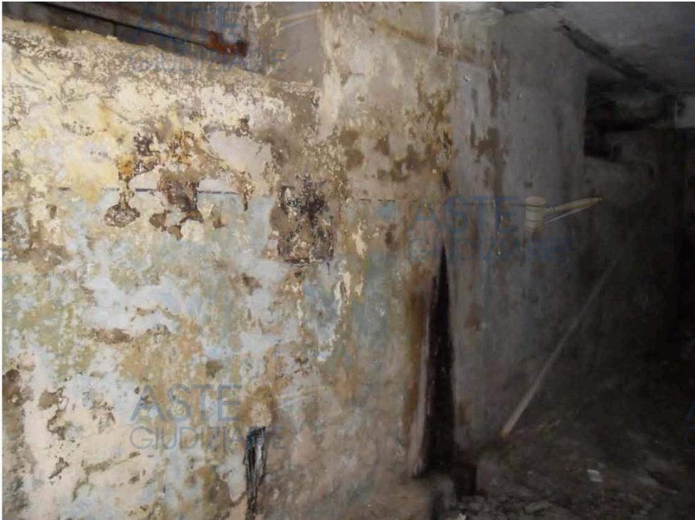
Foto n.11: dettaglio ammaloramento delle pareti perimetrali dell'autorimessa
