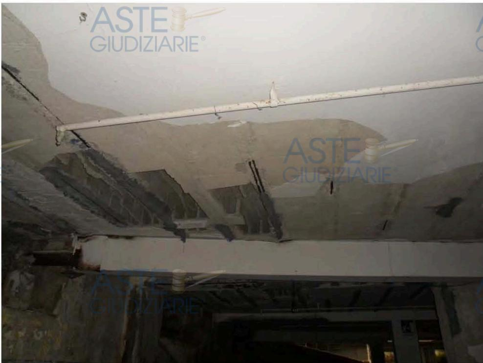
Foto n.9: dettaglio parte di solai danneggiati della autorimessa
