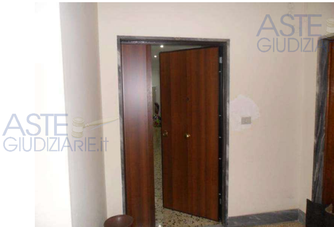
Foto n.1: porta di accesso interno 23
