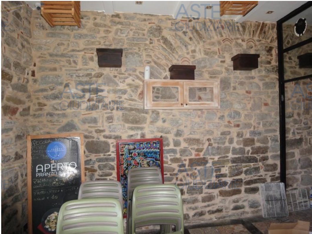
Foto 7- vano ingresso del locale
