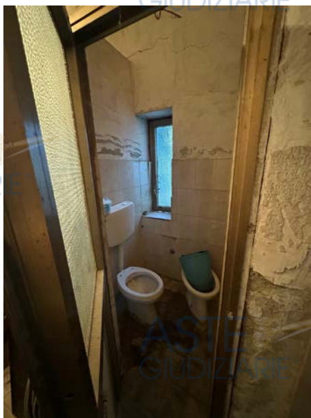
Foto 17: primo bagno a servizio del predetto locale spogliatoio
