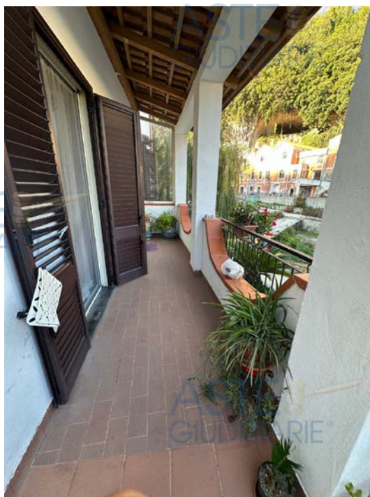
Foto 26: Particolare porzione di terrazzo coperta con tettoia, in corrispondenza dell'accesso alla casa del custode
