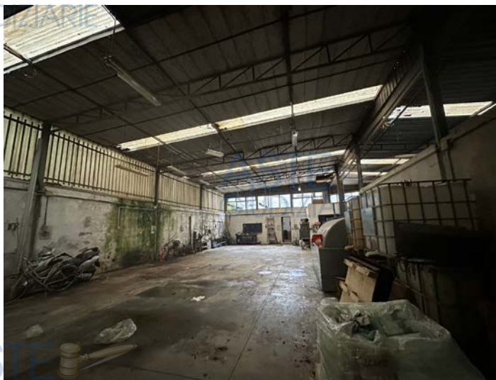
Foto 45: Vista di insieme del primo corpo di fabbrica privo di automezzi
