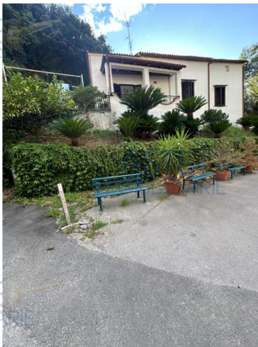
Foto 41: Vista di insieme della casa del custode
