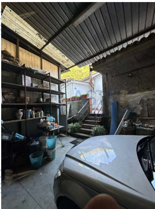
Foto 19: Vista della scaletta di collegamento tra il secondo corpo di fabbrica e la casa del custode con adiacente ufficio
