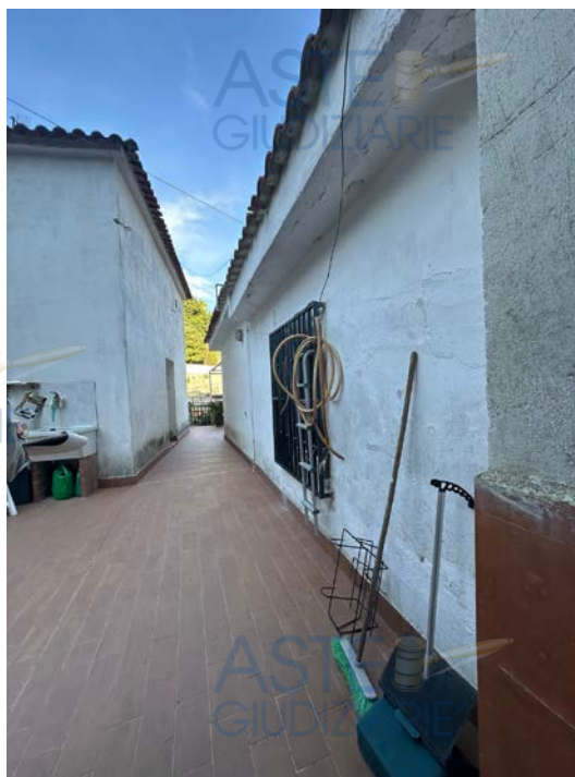
Foto 24: Particolare del terrazzo a servizio della casa del custode (a sx) ed all'ufficio (a dx)
