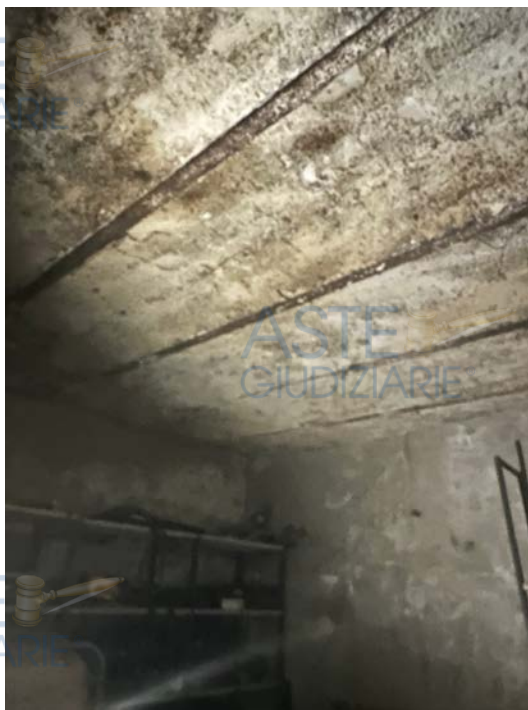
Foto 43: Vista interna del deposito di cui alla foto precedente
