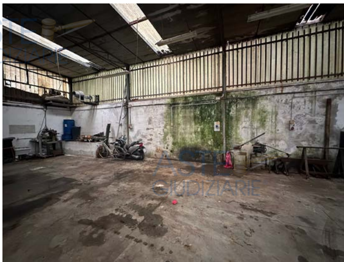
Foto 46: Altra vista di insieme del primo corpo di fabbrica
