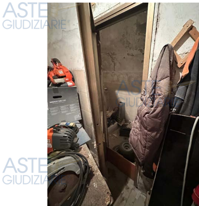
Foto 18: Secondo bagno (soppalcato) a servizio del locale spogliatoio
