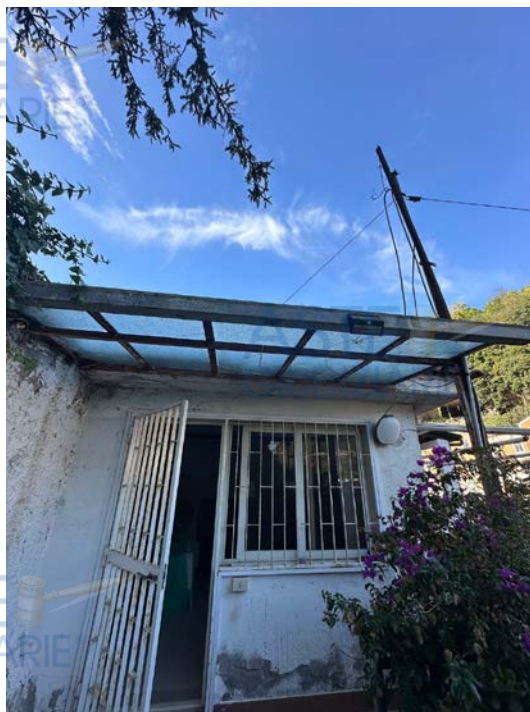
Foto 37: Particolare della porta di accesso all'ufficio di cui alla foto precedente
