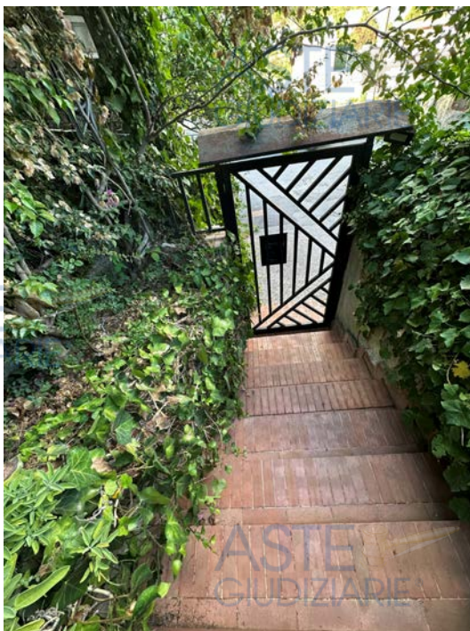
Foto 40: Scala di accesso dalla strada alla casa del custode e adiacente ufficio
