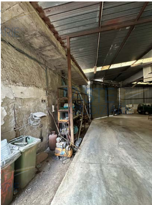
Foto 13: Altra vista interna del secondo corpo di fabbrica
