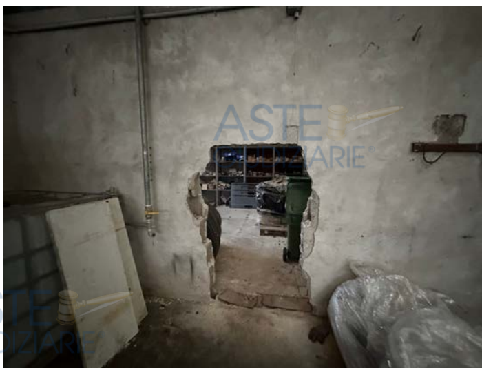
Foto 47: Vano di accesso tra il primo e il secondo corpo di fabbrica
