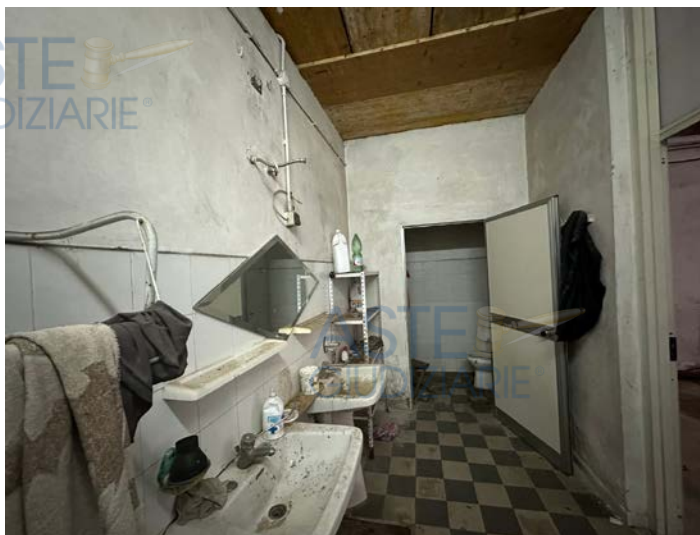
Foto 54: Locale Bagno e antibagno annessi al primo corpo di fabbrica
