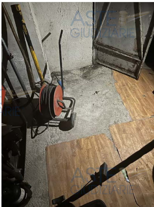
Foto 44: Particolare della pavimentazione del deposito di cui alla foto precedente
