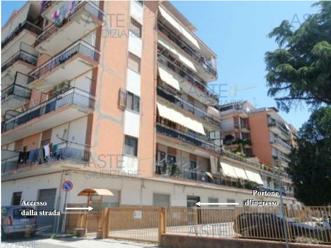
Foto esterna del Fabbricato
