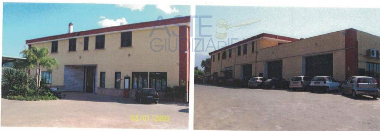
Le strutture sono in cemento armato, le compagnature in doppia fodera di laterizio, le pareti intonacate e ben tinteggiate, i pavimenti sono in cemento all'interrato, in klinker ceramico e cotto ai piani superiori, gli infissi in legno e metallo, le rifiniture sono di pregiato livello.
