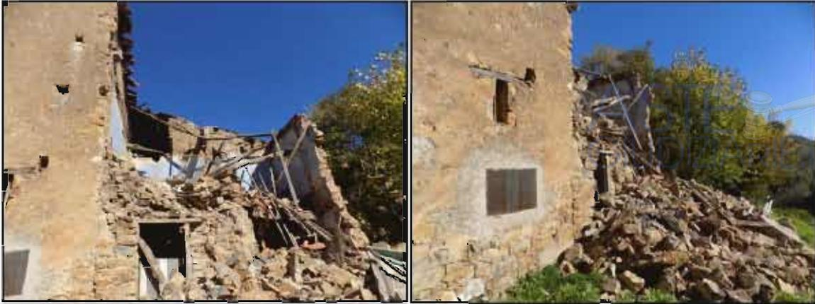
**Foto 6-7:** dettagli dell'esito dell'evento franoso che ha colpito i corpi di fabbrica part.lle 587 e 604 (estranee alla presente procedura), evento che ha determinato l'interdizione all'accesso agli interni del fabbricato di ricaduta delle part.lle 231 e 607.
