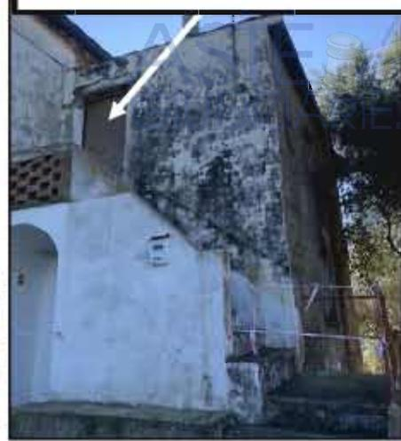
*Foto 2-3-4-5: viste degli esterni del fabbricato part.lla 607, il cui sub. 3 al piano primo è pignorato nella presente procedura. L'edificio, di remota costruzione in muratura portante, presenta ingresso esterno tramite scala ad unica rampa. All'attualità, l'accesso agli interni dell'abitazione è interdetto per la presenza dei sigilli delle Autorità predisposte, a causa di un evento franoso che ha colpito il fabbricato nelle part.lle 587 e 604 (estraneae alla presente procedura).*
