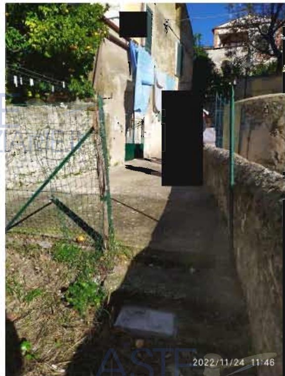
Area pertinenziale esterna pavimentata in cemento
