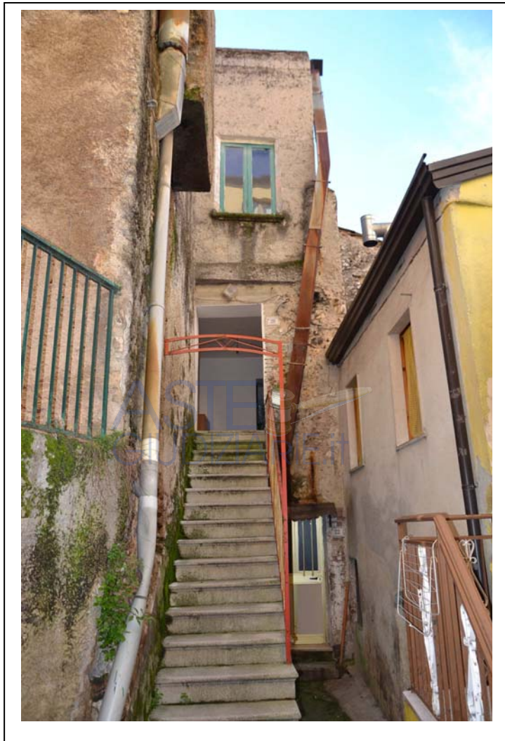
ingresso da Via Salvo D'Acquisto
