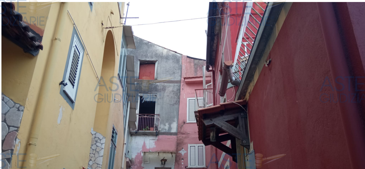
FOTO 3: inquadramento generale del fabbricato al cui piano terra ricade il lotto unico.
