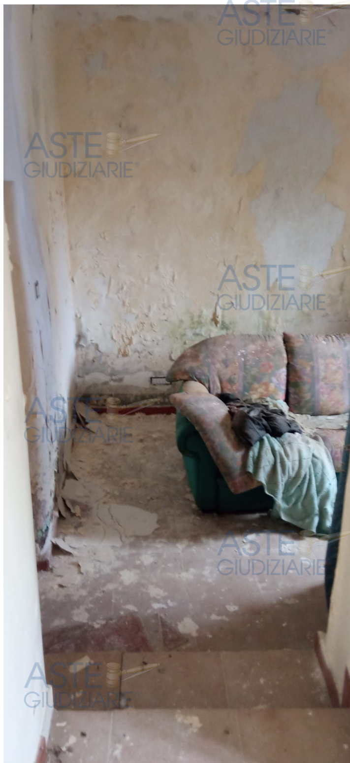
FOTO 8: vano secondo, presumibilmente salotto, con scalini che conducono ad altro vano camera.
