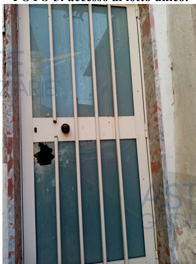
FOTO 6: dettaglio dell'infisso di ingresso.
