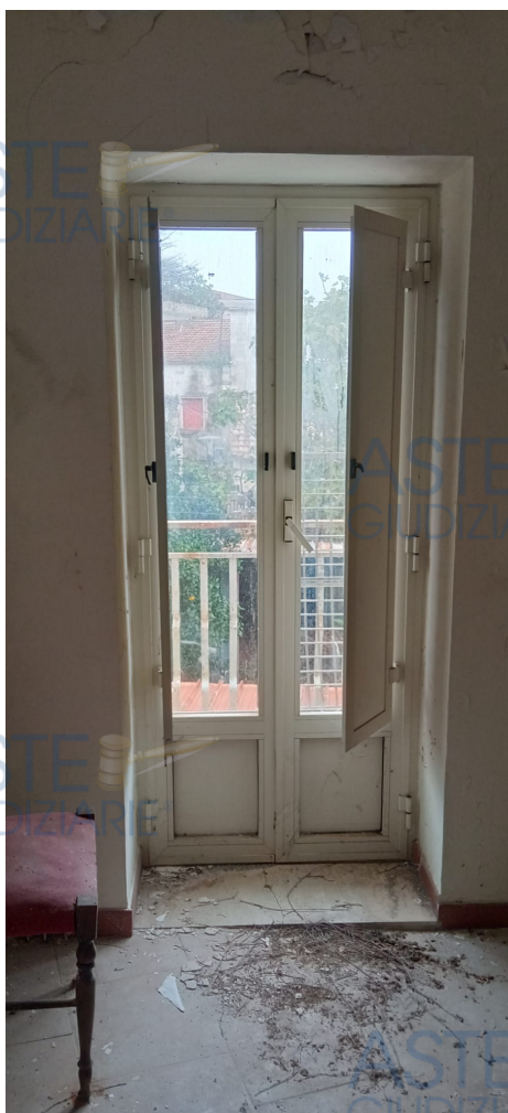
FOTO 15: dettaglio dell'infisso del vano camera con affaccio ad Est.
