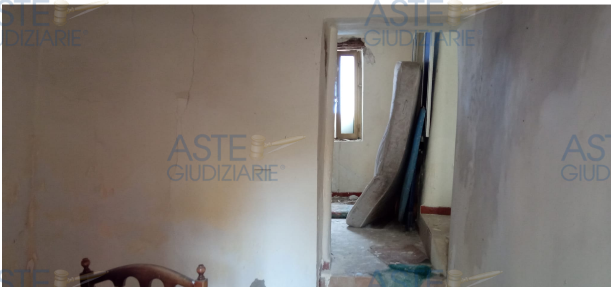
FOTO 11: visione generale della distribuzione dei vani interni.
