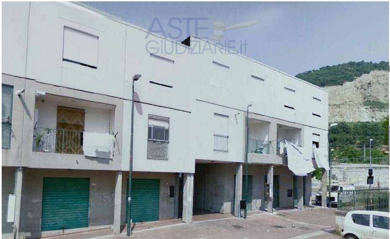
Foto n. 2 – ingresso viale Tramontana - prospetto Ovest
