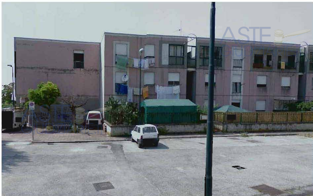
Foto n. 3 – prospetto Nord fabbricato
