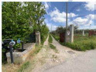
Accesso al fabbricato
