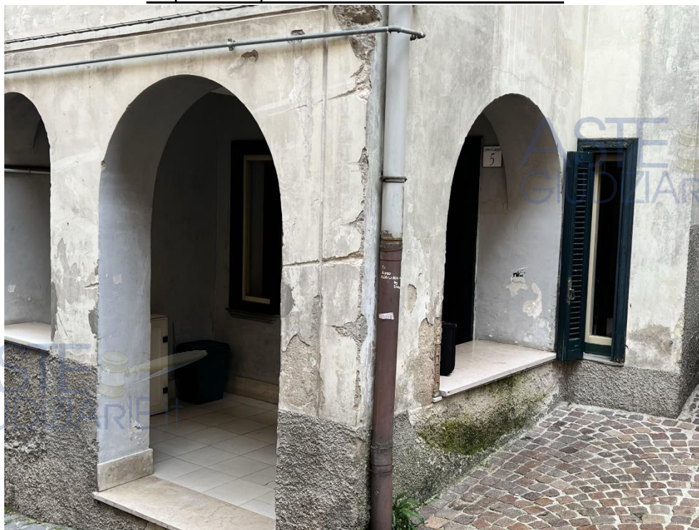
Foto 4 – Ingresso comune al fabbricato di ubicazione del Lotto unico pignorato. Si notino le finiture complessivamente in mediocri condizioni di conservazione e manutenzione, con necessità di ripristinare gli intonaci.
