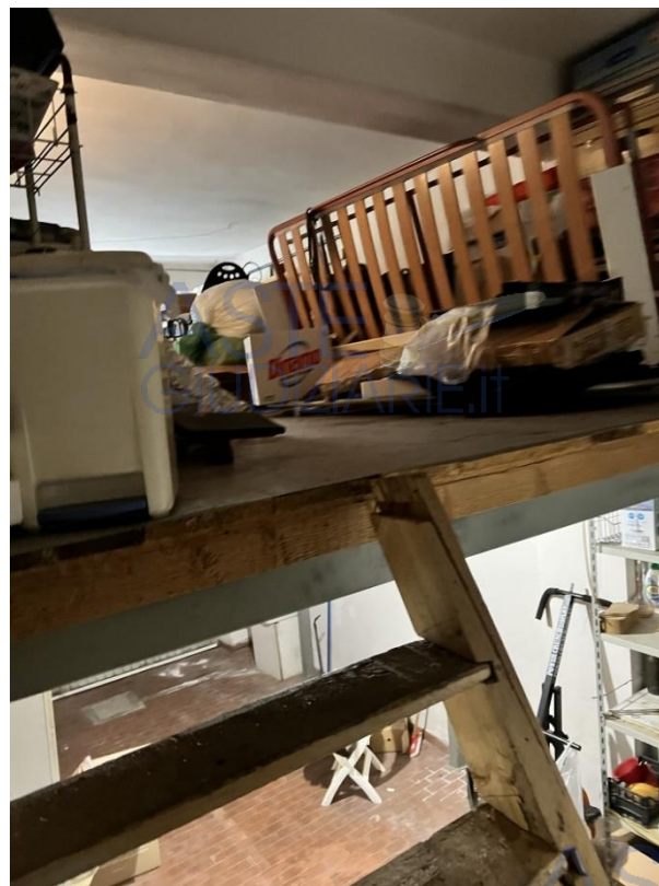
Foto 17 – Locale autorimessa, dotato di piccolo soppalco.
