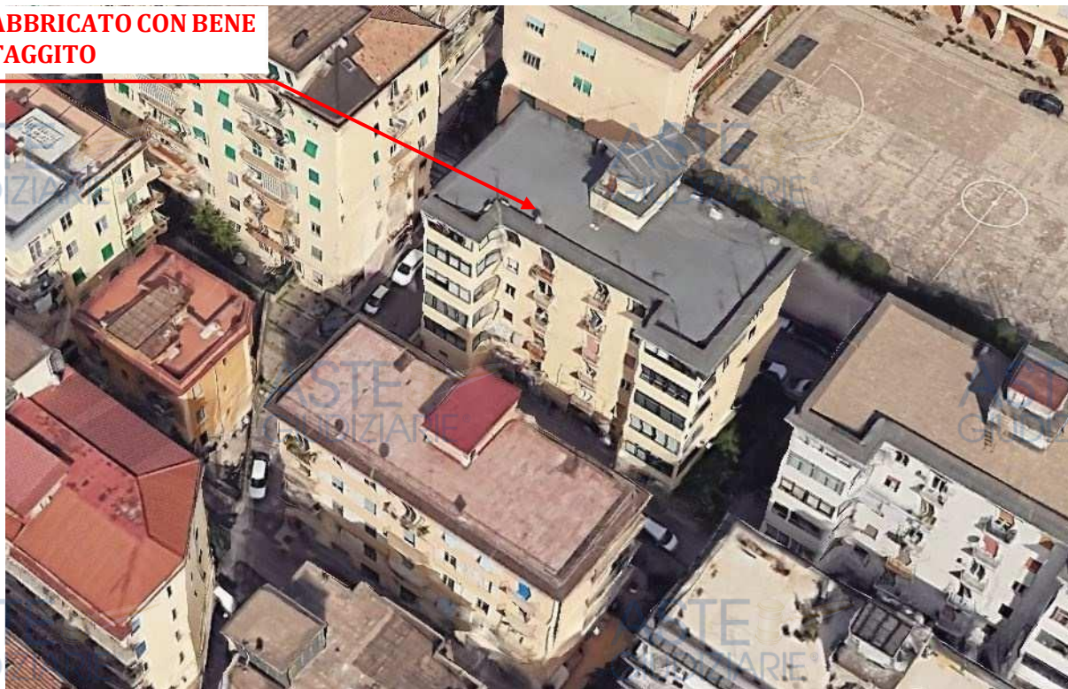
Figura 2: Dettaglio su ortofoto del fabbricato con immobile staggito (Fonte: Google Maps)
