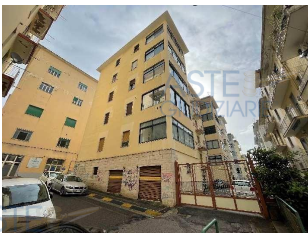
Figura 5: Vista dello stabile da Via San Domenico Savio
