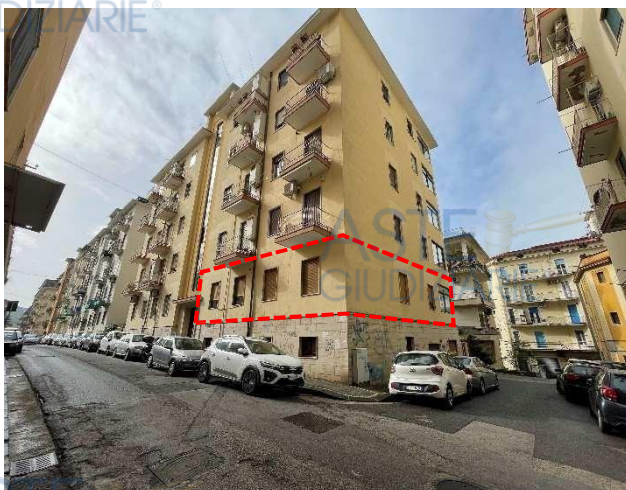
Figura 3: Vista dello stabile da Via F. La Francesca con indicazione dell'immobile staggito
