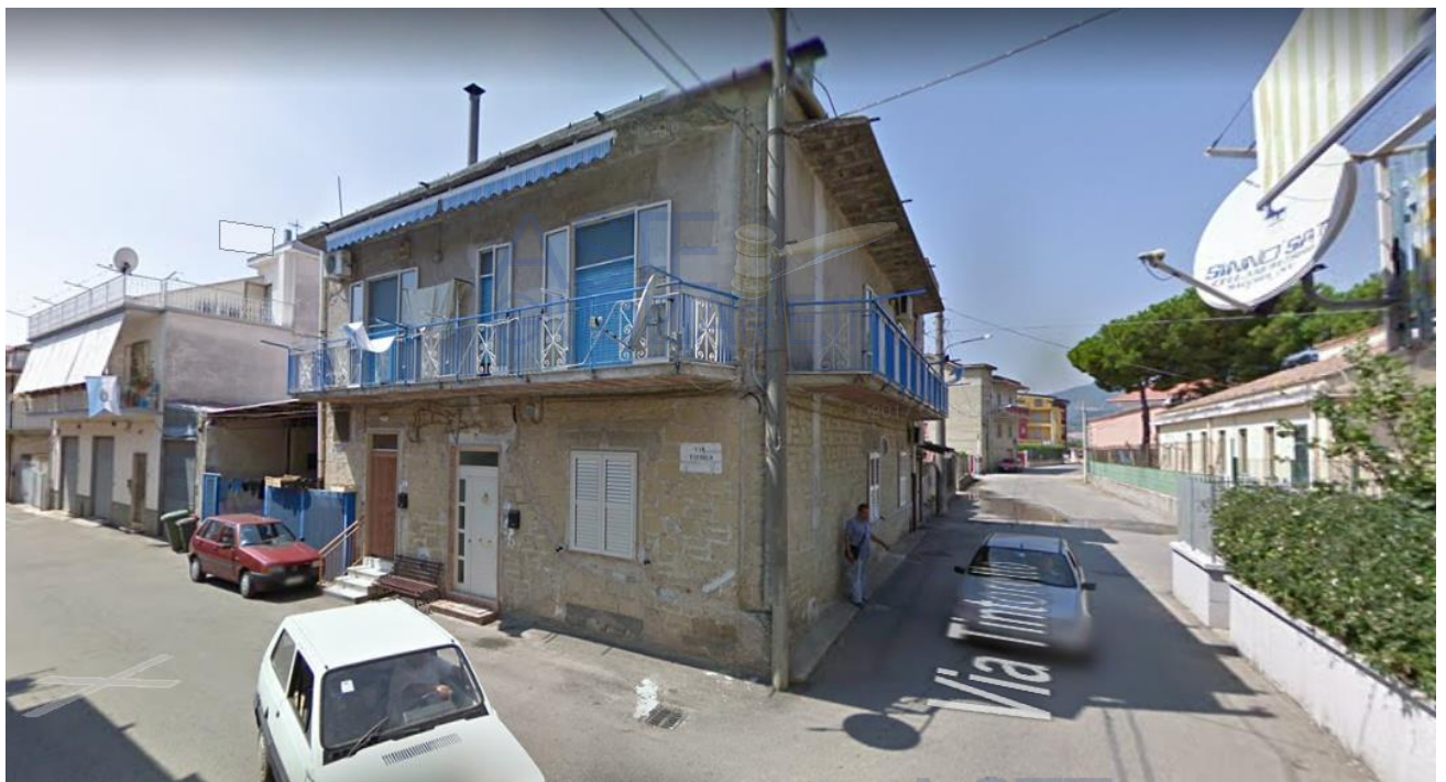
Vista d'insieme de fabbricato di ubicazione lotti ripreso dall'incrocio di Via Tiepolo e Via Tintoretto
